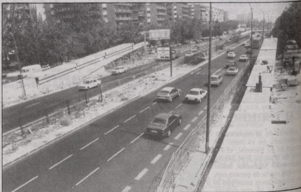
Obras de la nueva pasarela
