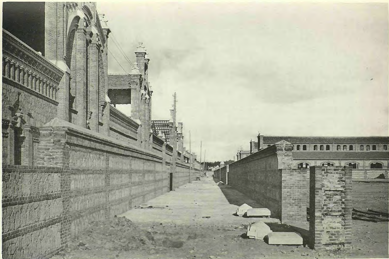
Callejón de intercomunicación entre los establos y las naves de degüello
