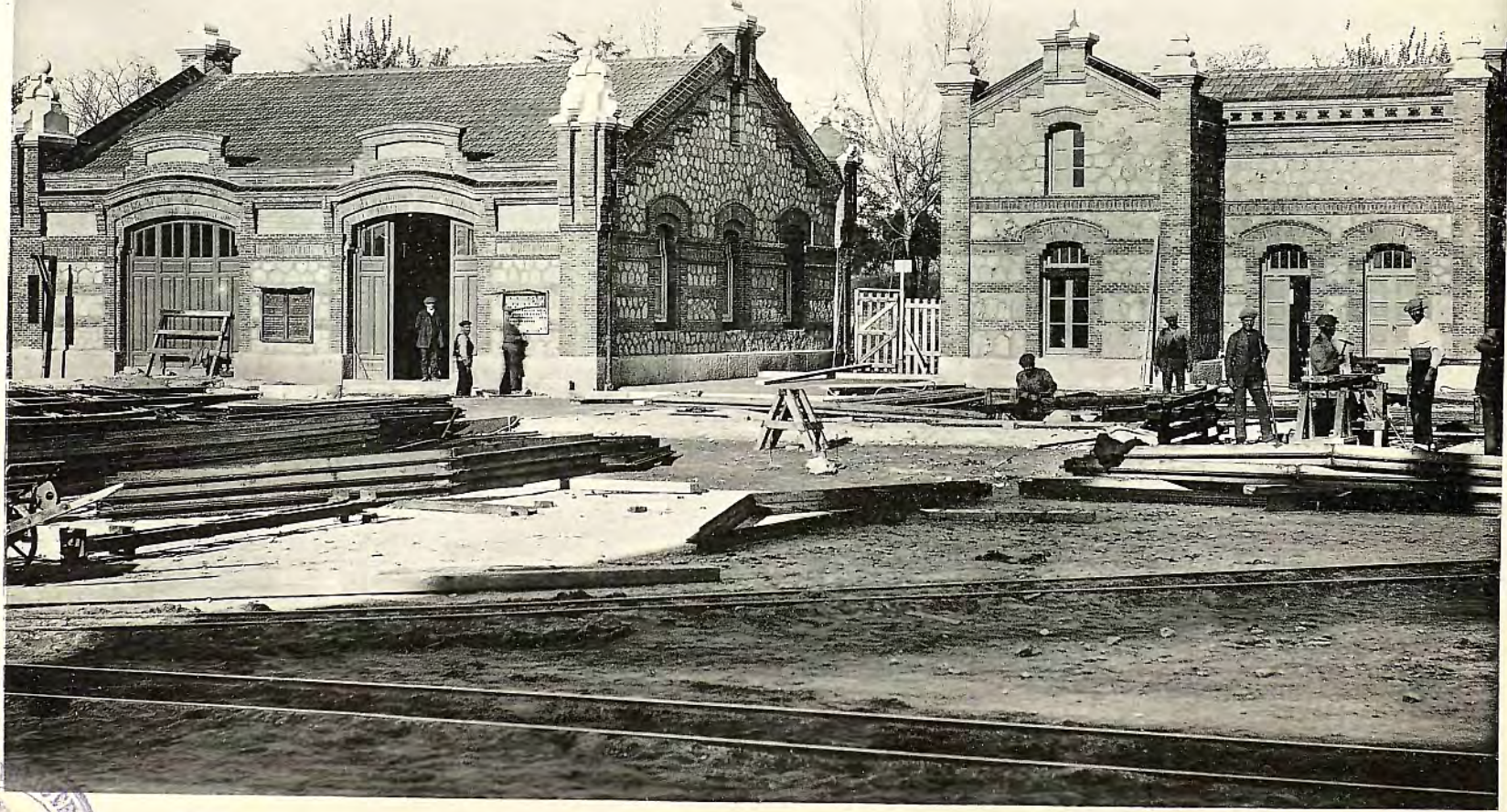
Puesto de Incendios
