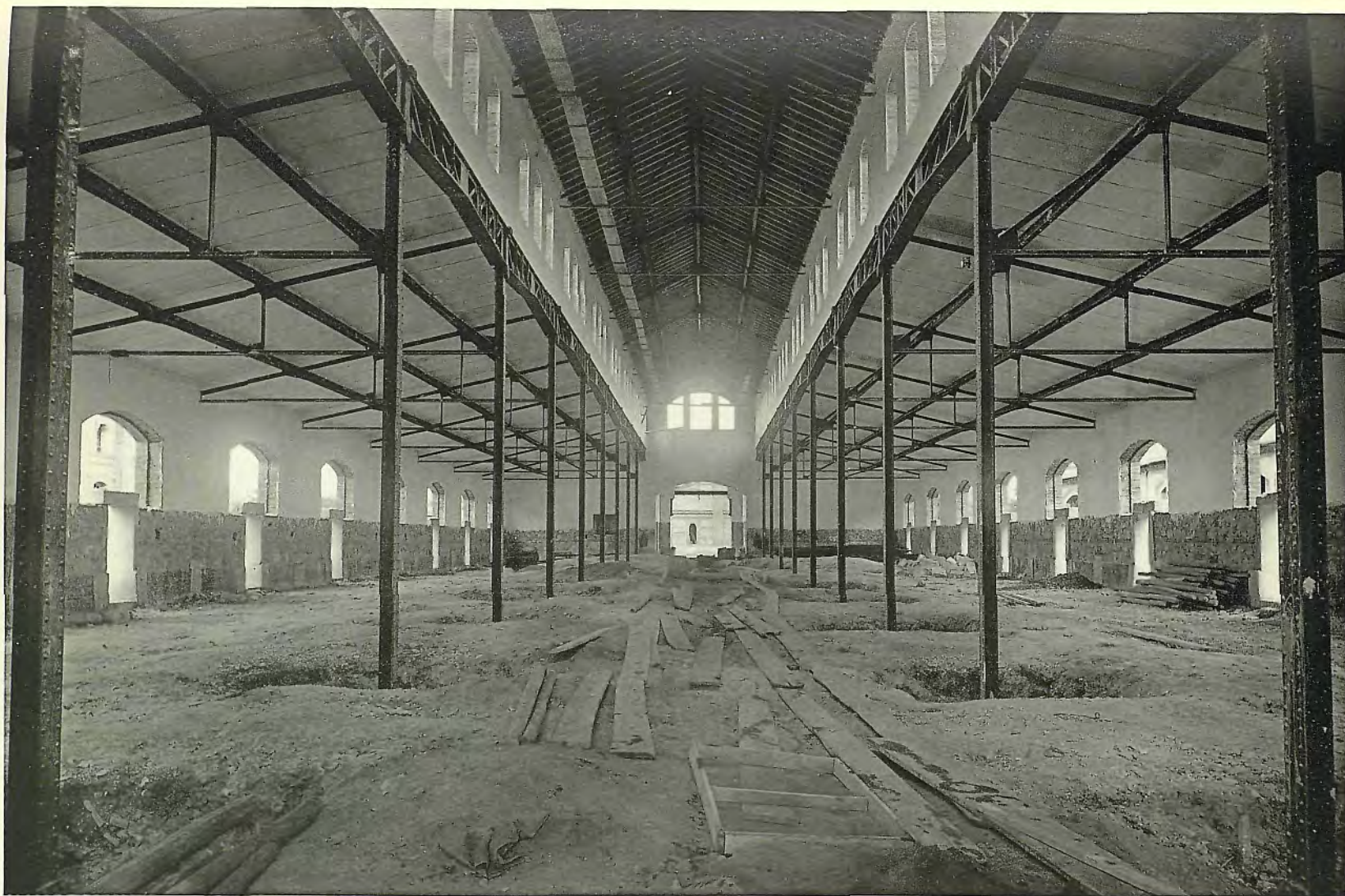
Una de las dos Naves de degüello de ganado vacuno Vista interior antes de la colocación de burladeros y pavimento
