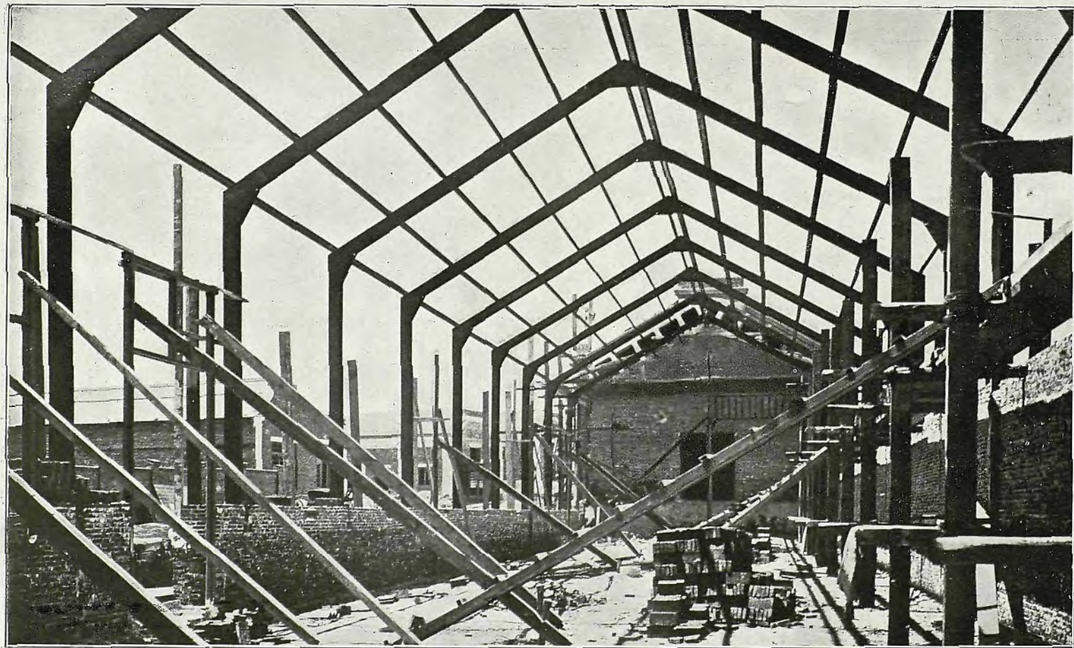
Nuevo Parque Central.—Detalle de las armaduras.
