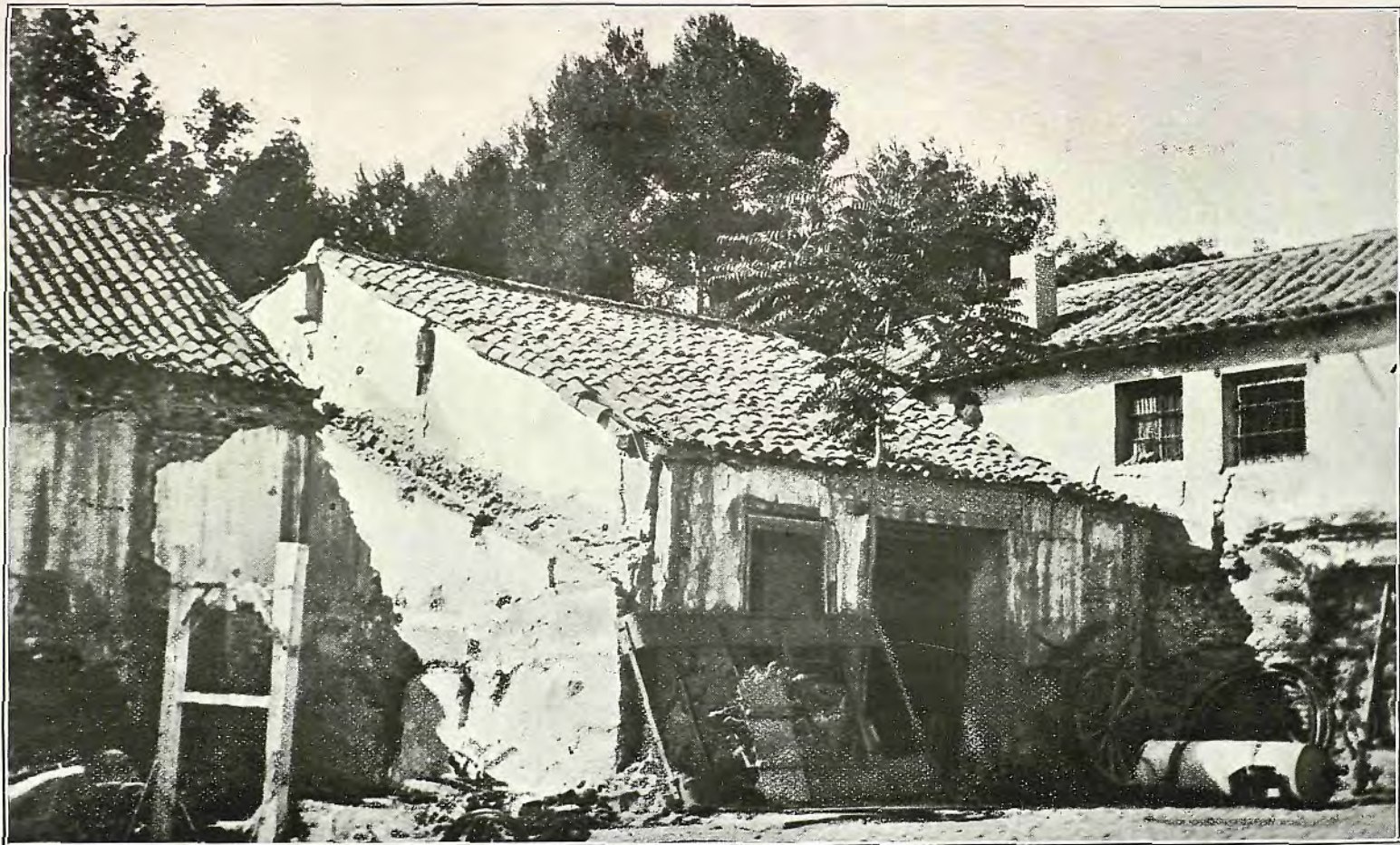
Parque de arrastres y talleres del Sur.—Un aspecto de las construcciones.
