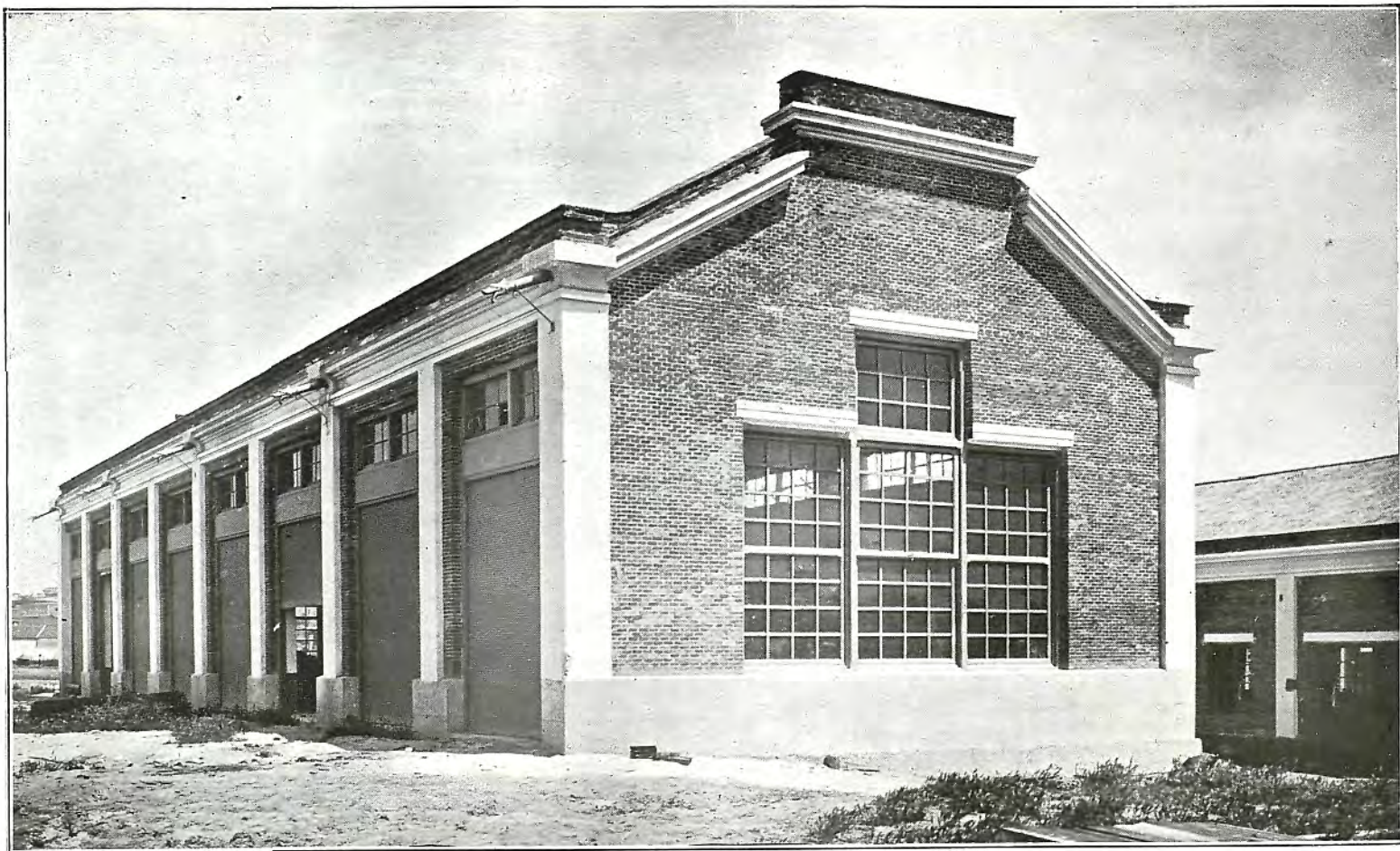
Nuevo Parque Central.—Un pabellón para material automóvil.
