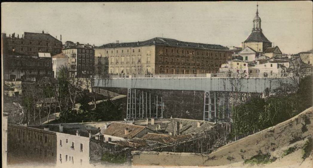
MADRID — Viaducto y Capitania General
