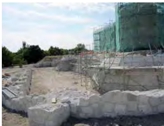
Restos del torreón de esquina en el lado noroeste.
