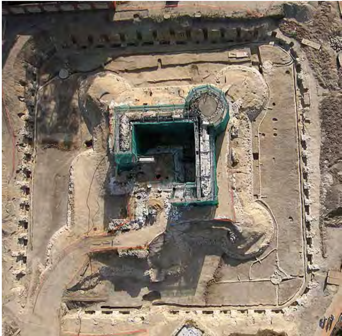
Fase inicial de las obras. Excavación arqueológica y consolidación de los muros del castillo (fotografía de Visión Aérea)
