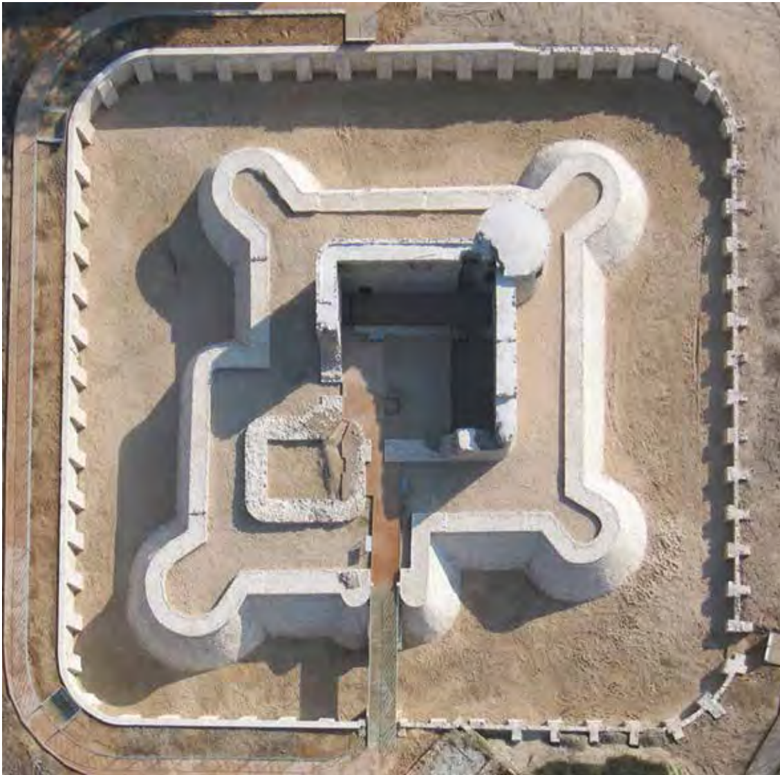
Imagen final de la obras de conservación y restitución de los restos. (fotografía de Visión Aérea)
