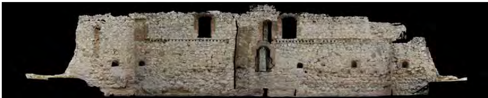
Foto panorámica interior del edificio principal
