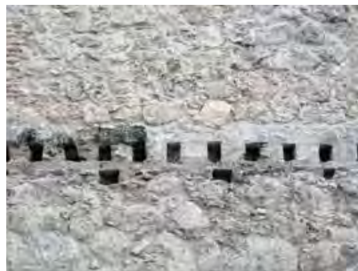
Cara interior del muro sur del castillo antes de la intervención de consolidación.
