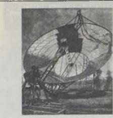
"Máquina instalada en Pasadena (California) para utilizar energía solar" 1901, n.º 1.027, p. 583.
