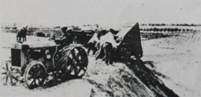
Trabajos de terraplenado.
