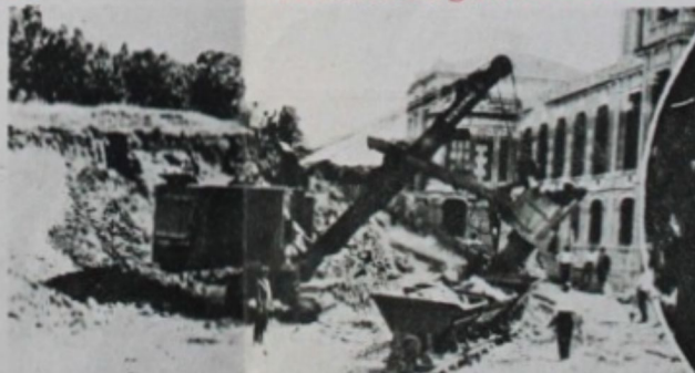
Una de las modernas máquinas excavadoras.
