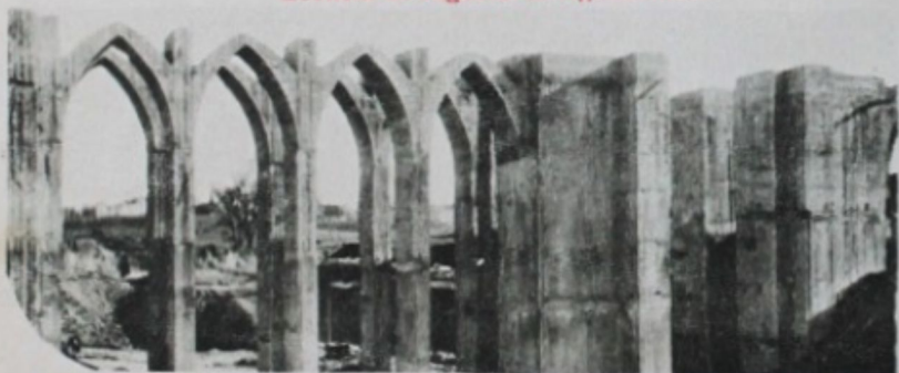
Viaducto de la gran Avenida de Alfonso XIII (en construcción).
