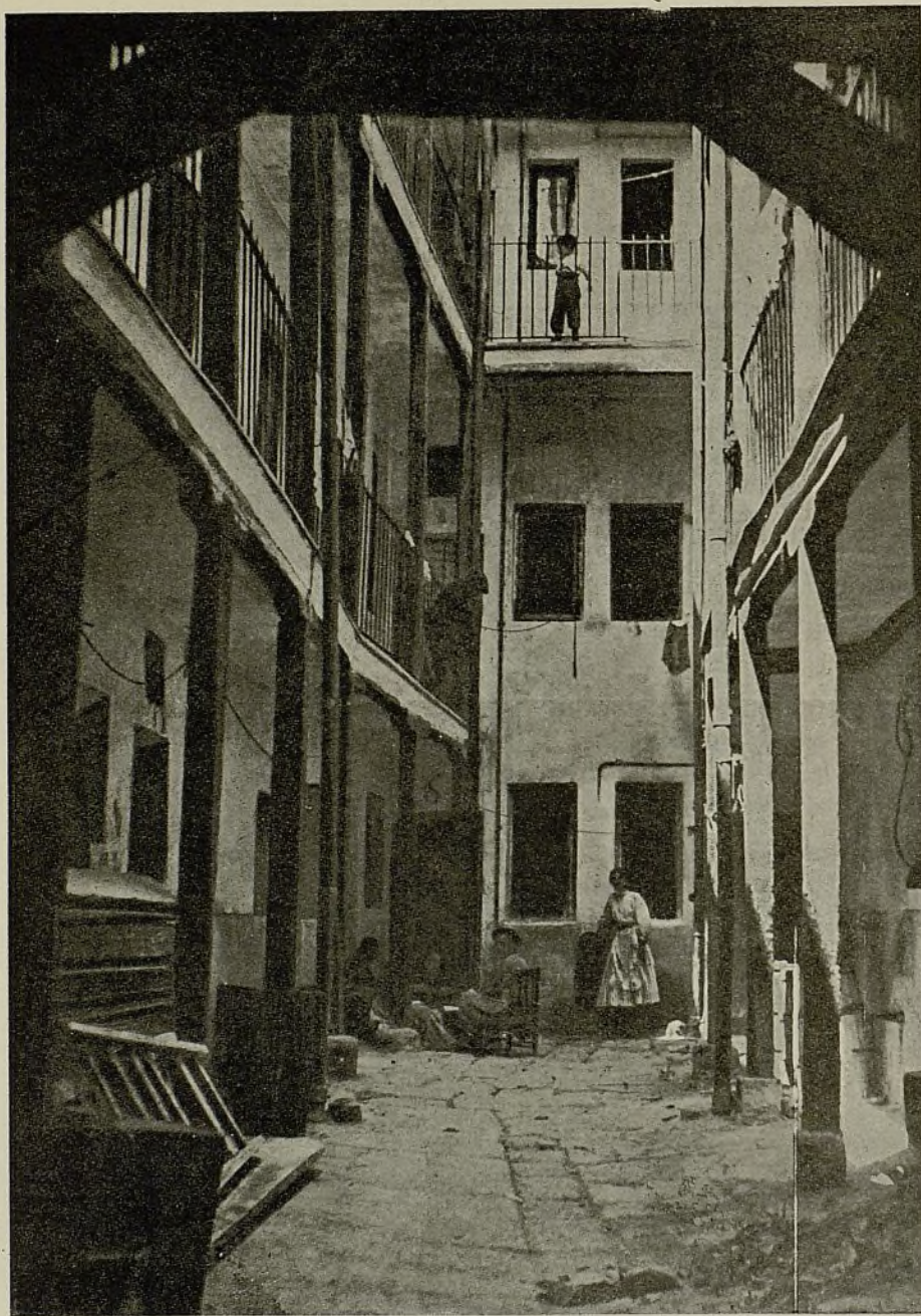
Calle de Mira el Río Alta.—Interior de la casa núm 8.—Distrito de la Latina, barrio de la Arganzuela.—Mortalidad del barrio: 38'18 por 1.000
