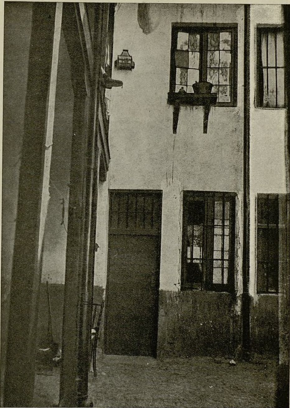
Calle de Rodas.-Interior de la casa núm. 11.
