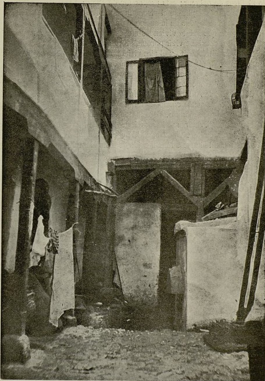
Calle del Rosario.—Interior de la casa núm. 19.—Distrito de la Latina, barrio de San Francisco.—Mortalidad del barrio: 39'69 por 1'000.
