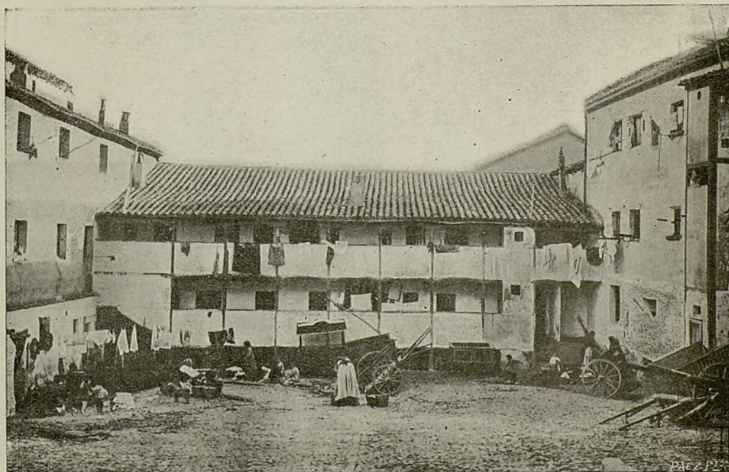
Callejón del Mellizo.—Interior de la casa núm. 4 duplicado.—Distrito de la Latina, barrio de la Arganzuela.—Mortalidad del barrio: 38'18 por 1.000.
