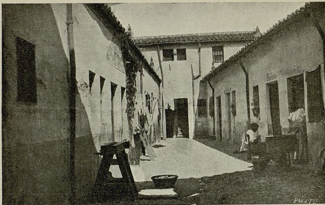
Calle de las Peñuelas.—Interior de la casa núm. 21.
