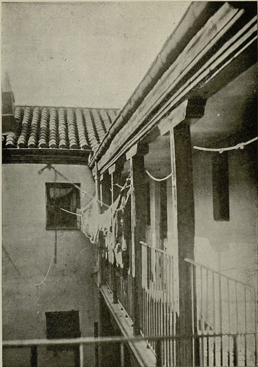
Calle del Salitre.—Galería de la casa núm. 36.—Distrito del Hospital, barrio de Primavera.—Mortalidad del barrio: 42'31 por 1.000.
