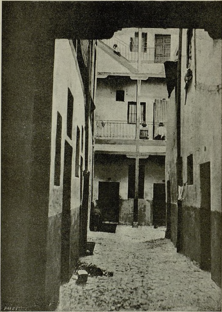
Calle de Rodas:—Interior de la casa núm. 3.—Distrito de la Inclusa, barrio de Huerta del Bayo.—Mortalidad del barrio: 40'50 por 1,000.
