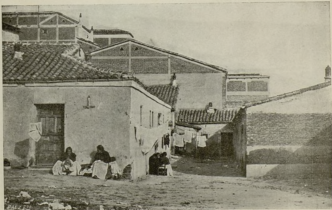
Calle de Carlos Latorre.—Distrito de la Universidad, barrio de Bellas Vistas. Mortalidad del barrio: 31'36 por 1.000.
