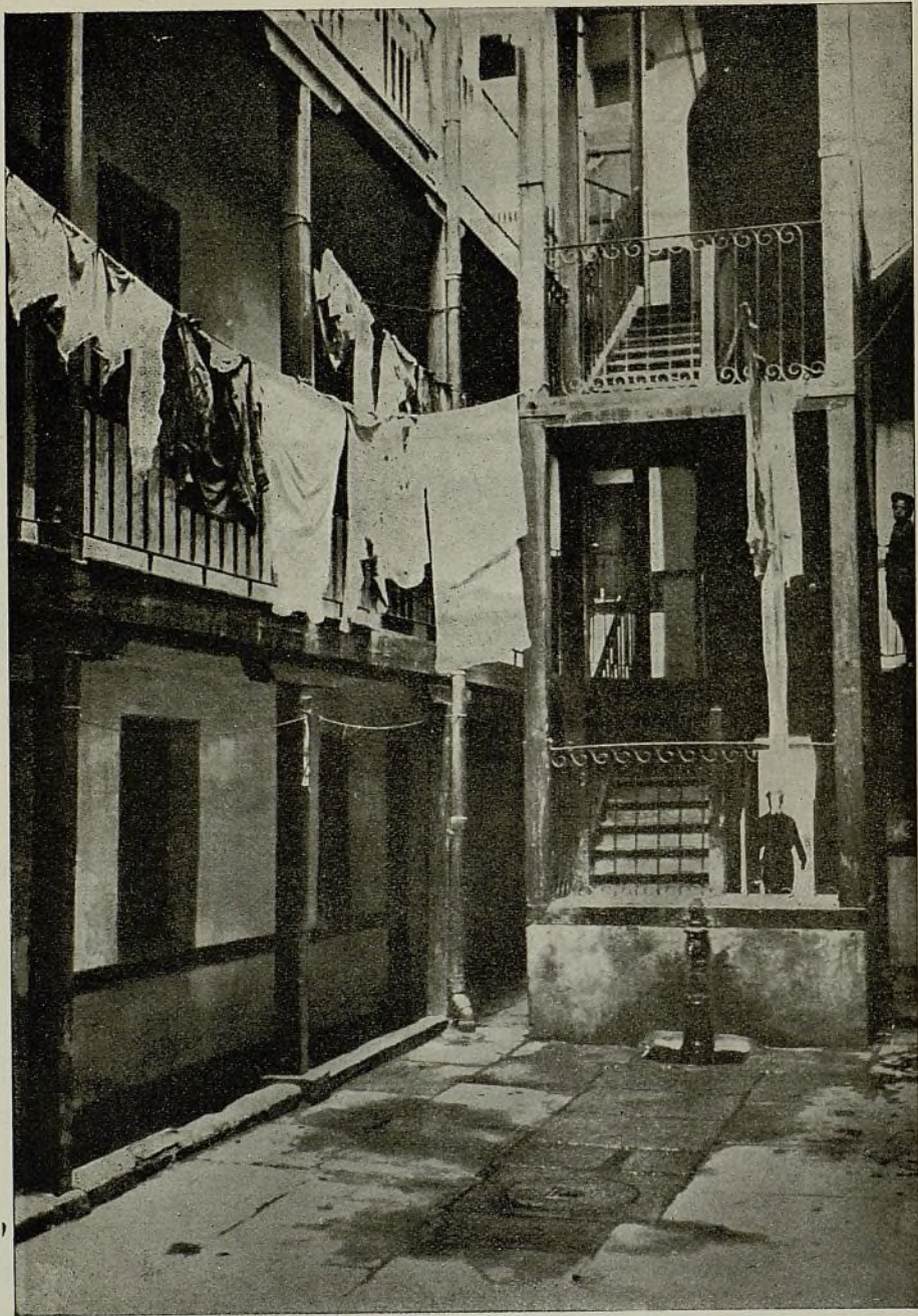
Calle de las Peñuelas.—Interior de la casa núm. 16.
