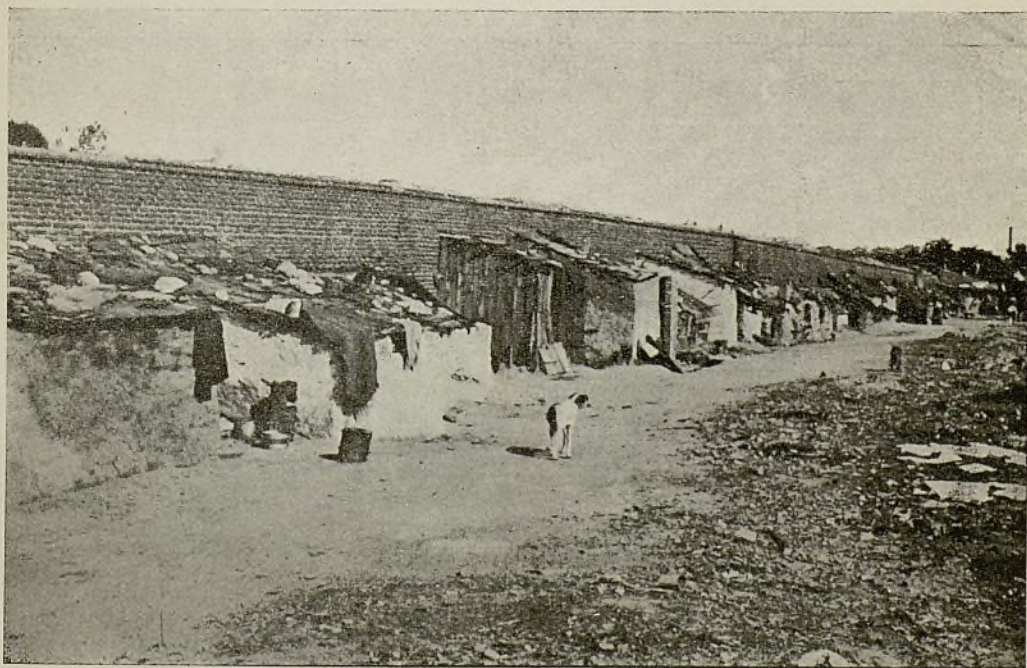
Chozas existentes en la calle de Magallanes, núm. 19, solar.—Distrito de la Universidad barrio de Lozoya.—Mortalidad del barrio: 33'59 por 1.000.
