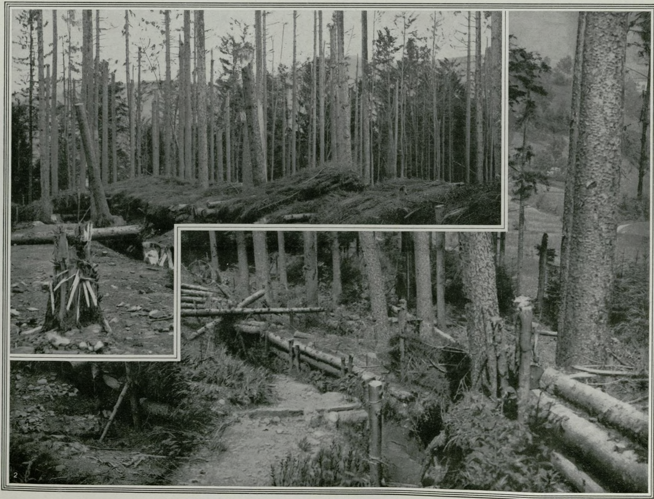
1 et 2. Les futaies détruites autour des tranchées.
