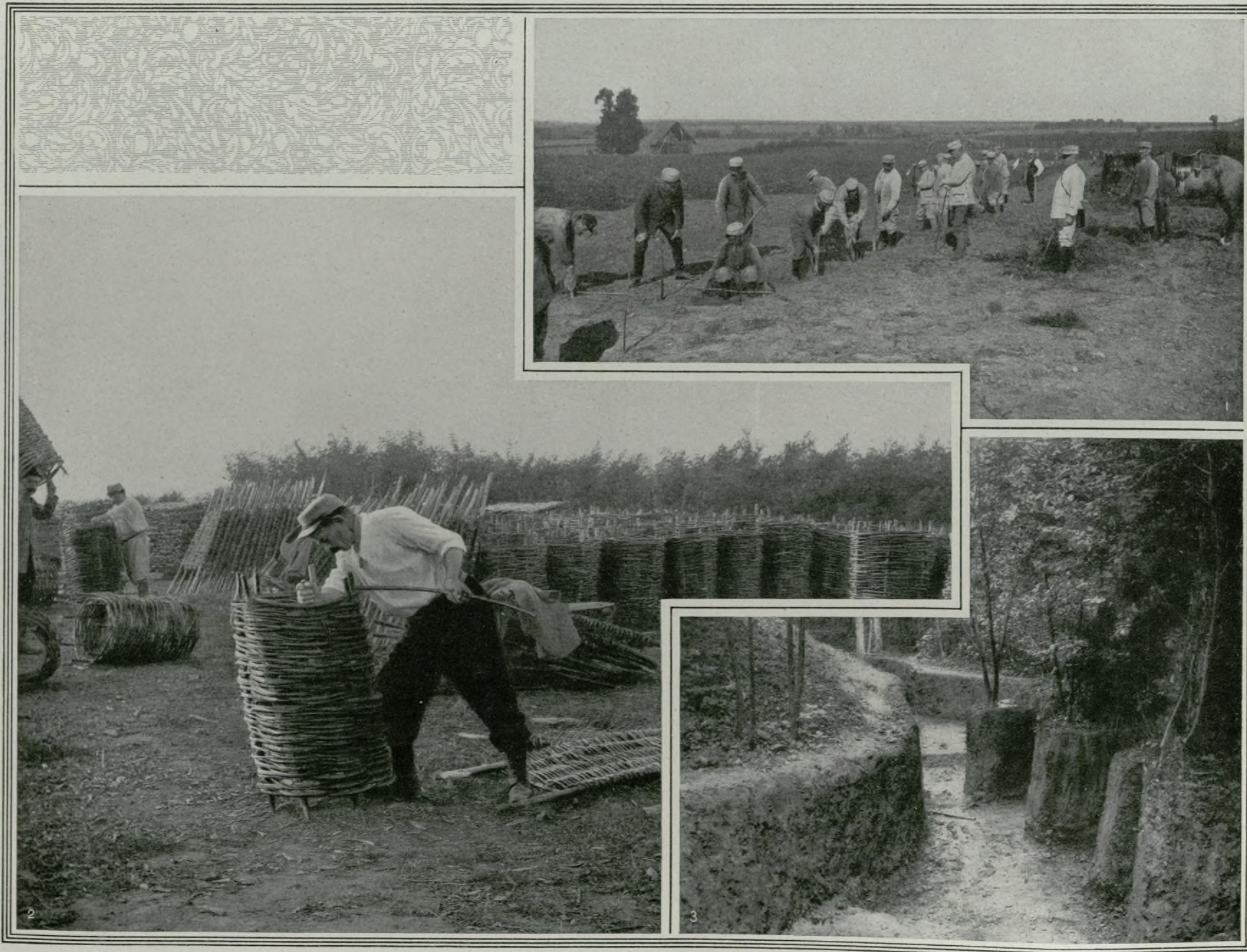
1. Équipe creusant une tranchée. — 2. Fabrication de gabions. — 3. Tranchée dans un bois.
