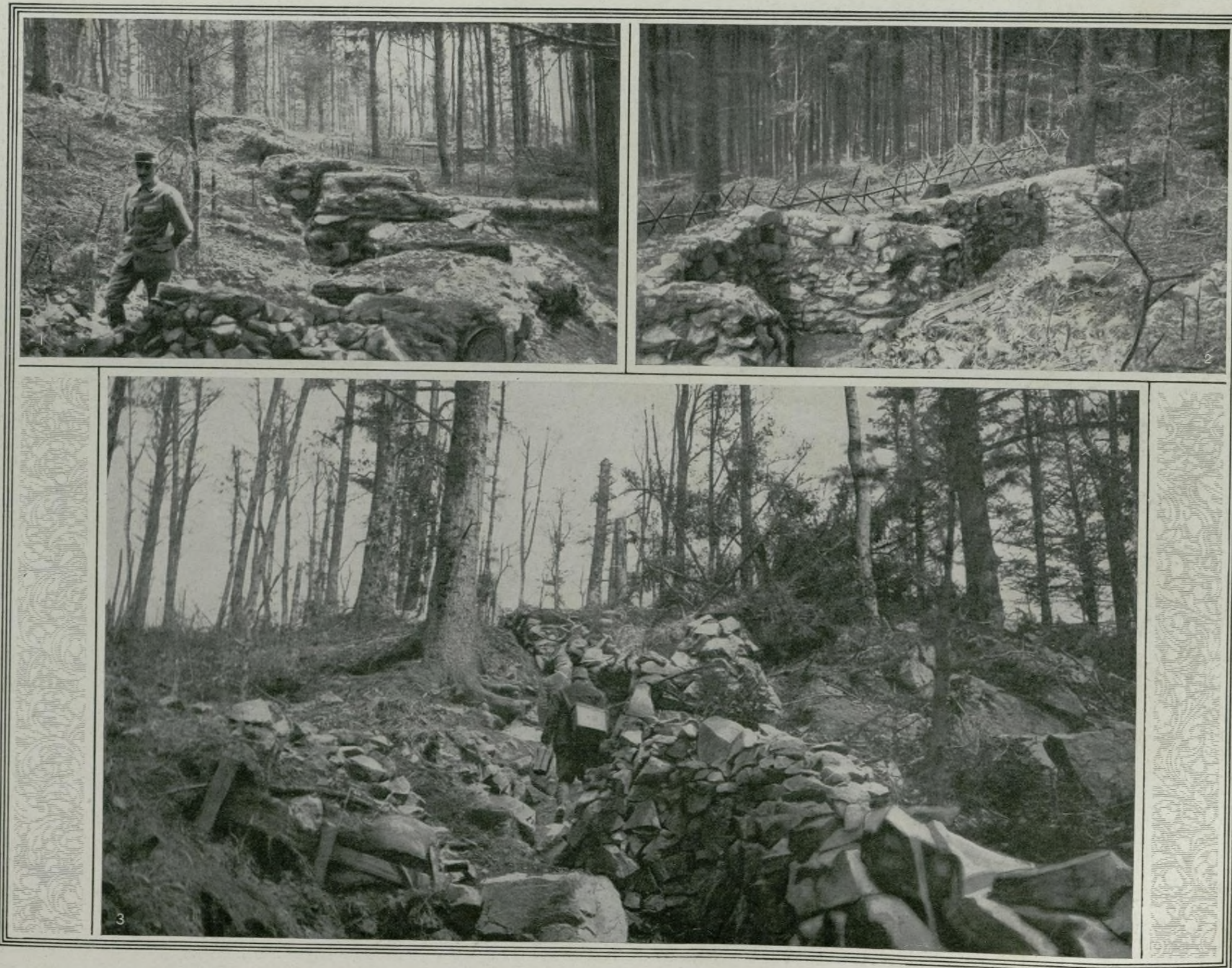
A l'Hartmannswillerkopf : 1. Tranchée sous bois. — 2. Chevaux de frise. — 3. Boyau de cheminement vers le sommet.
