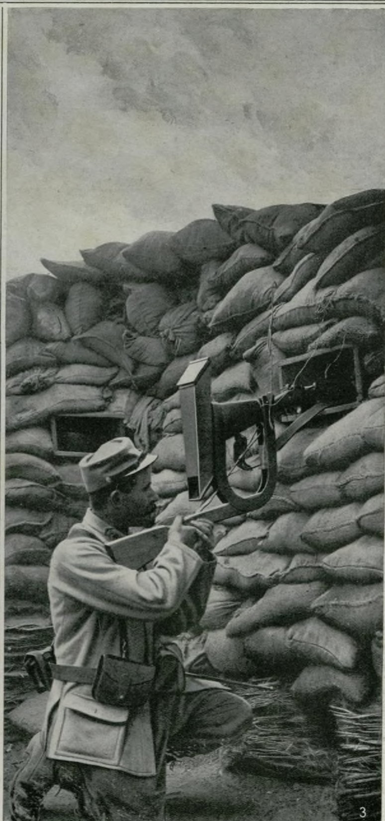
1. Tranchée gabionnée. — 2. Réglage des tirs d'artillerie d'une tranchée de première ligne. — 3. Parapet de sacs de sable; fusil à crose périscopique.
