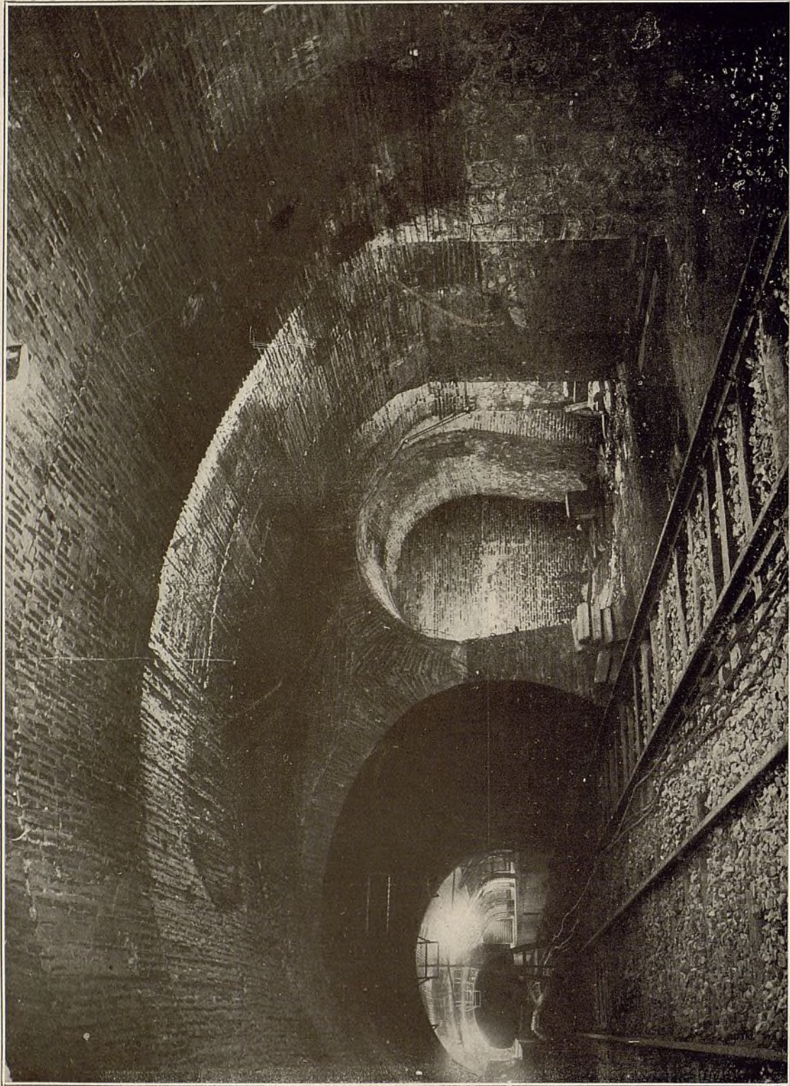
Fig. 3. a —SECCIÓN TELESCÓPICA DE PROGRESO.—En primer término el ensanchamiento telescópico construído; a la derecha la boquilla del túnel de enlace, de vía sencilla, de la futura estación de los Barrios Bajos; a la izquierda el túnel de la línea Norte-Sur, y la actual estación de Progreso.
