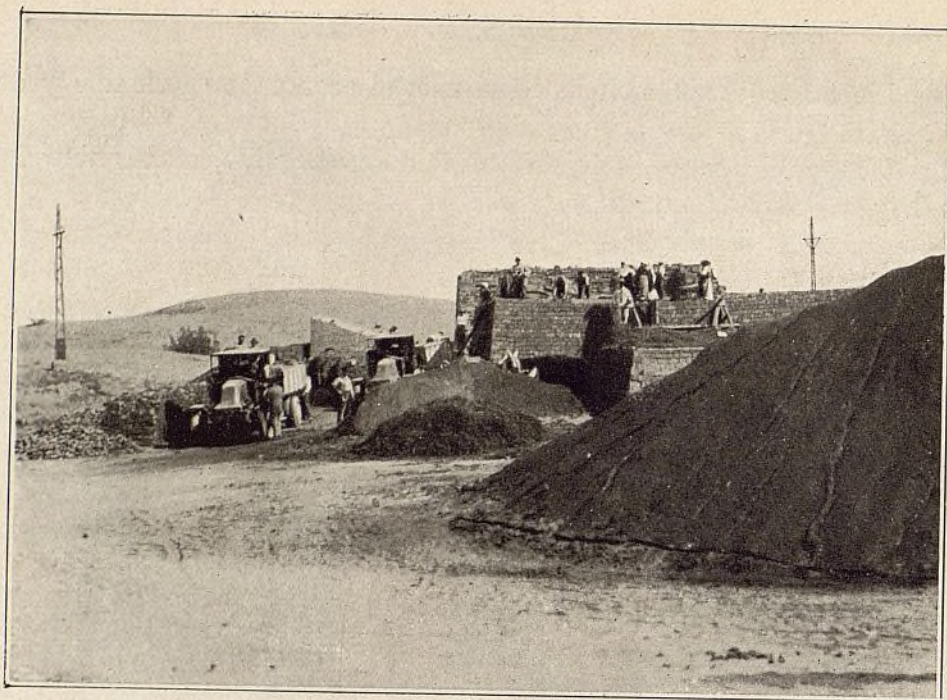
Fig. 26.—Tejar de la Bodeguilla. Tiene capacidad para cortar 2.500.000 ladrillos en una campaña.
