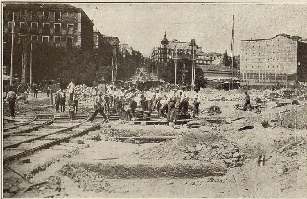
Fig. 5. a .—Construcción de la Estación de Atocha.
