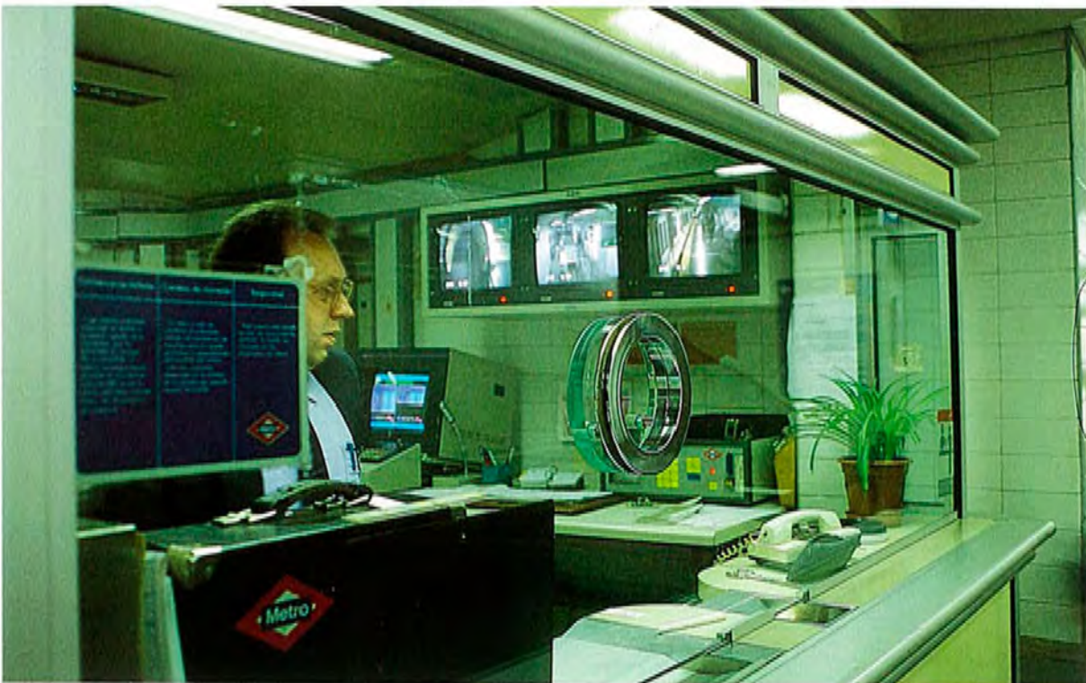
Puesto de Control Local: Nuevo puesto de expendición de billetes y control de las instalaciones de la estación.
