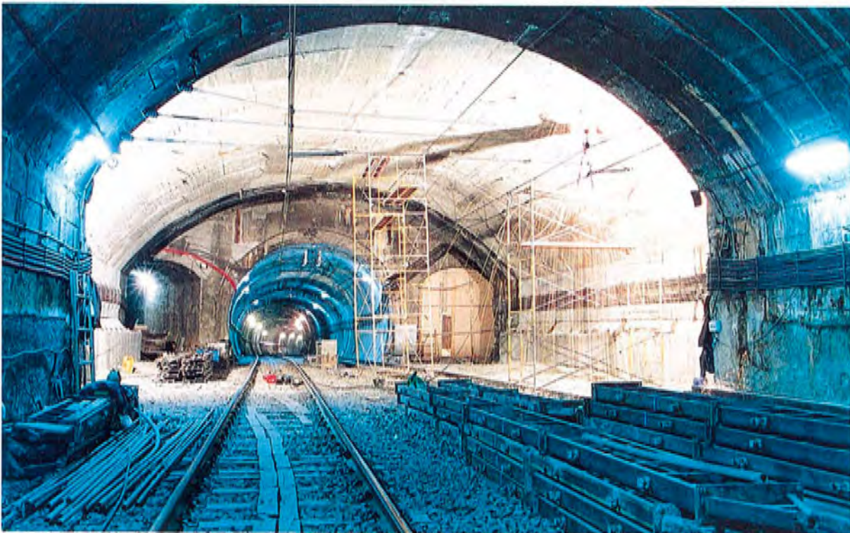
Obras de ampliación de L.6 tramo Laguna-Lucero y tunelillos de enlace a cocheras.
