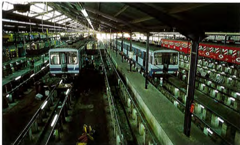
Nave de Mantenimiento del recinto de Canillejas.
