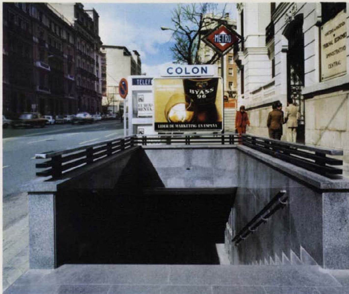
Nuevo acceso a la estación de Colón.
