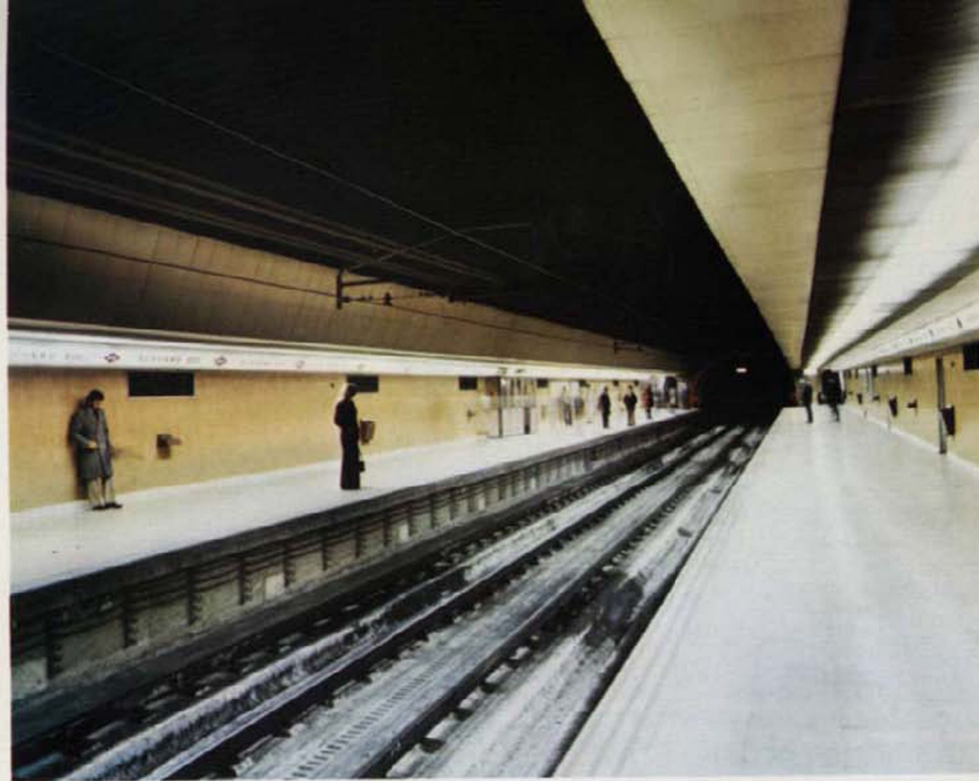
Estación de Alfonso XIII (prolongación de línea 4).
