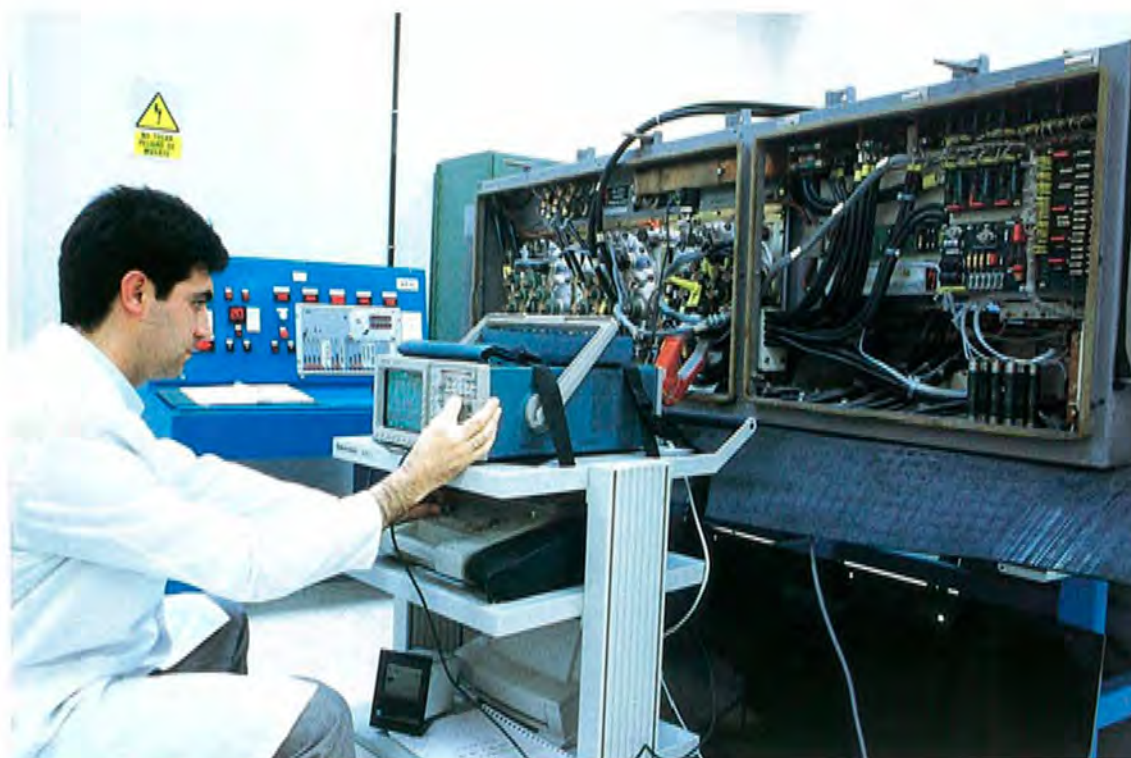
Taller Central de Canillejas. Zona de pruebas de Electrónica de potencia.
