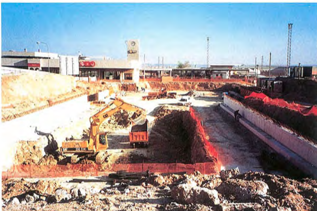
Ampliación Línea 9. Comienzo de obras de la estación de Vicálvaro-Renfe.
