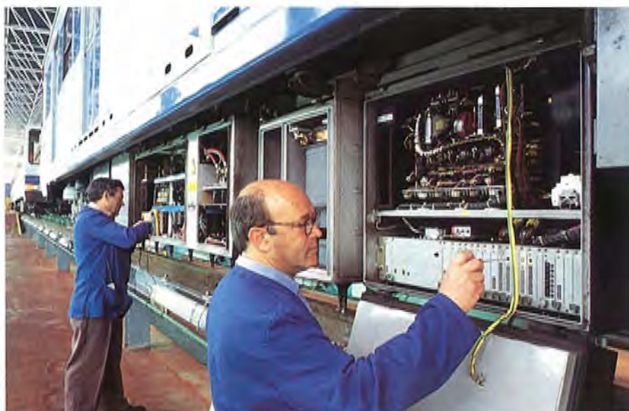
Operaciones de revisión sobre el aparellaje eléctrico y electrónico de los cofres situados en la parte inferior de los coches 5000.
