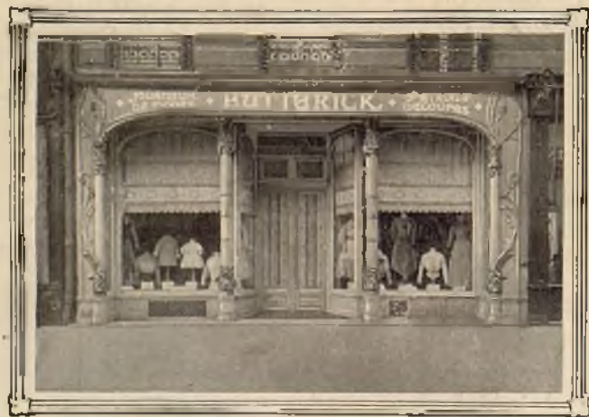
Façade de notre magasin, 27, avenue de l'Opéra
