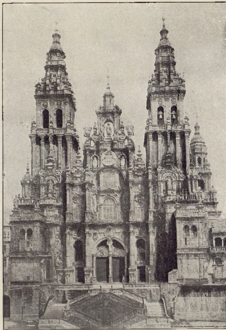
Fachada principal de la catedral de Santiago
