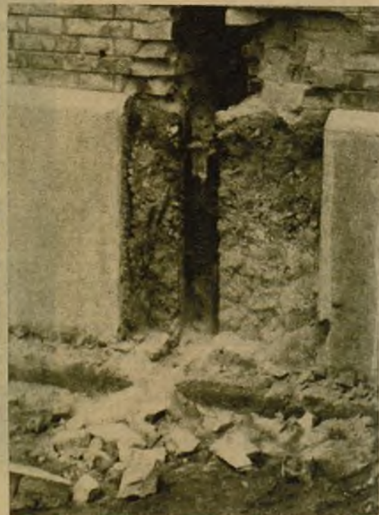
Vista de los deterioros que produjo en un muro la explosión de un petardo en una iglesia en construcción en el paseo de la Palmera, de Sevilla
