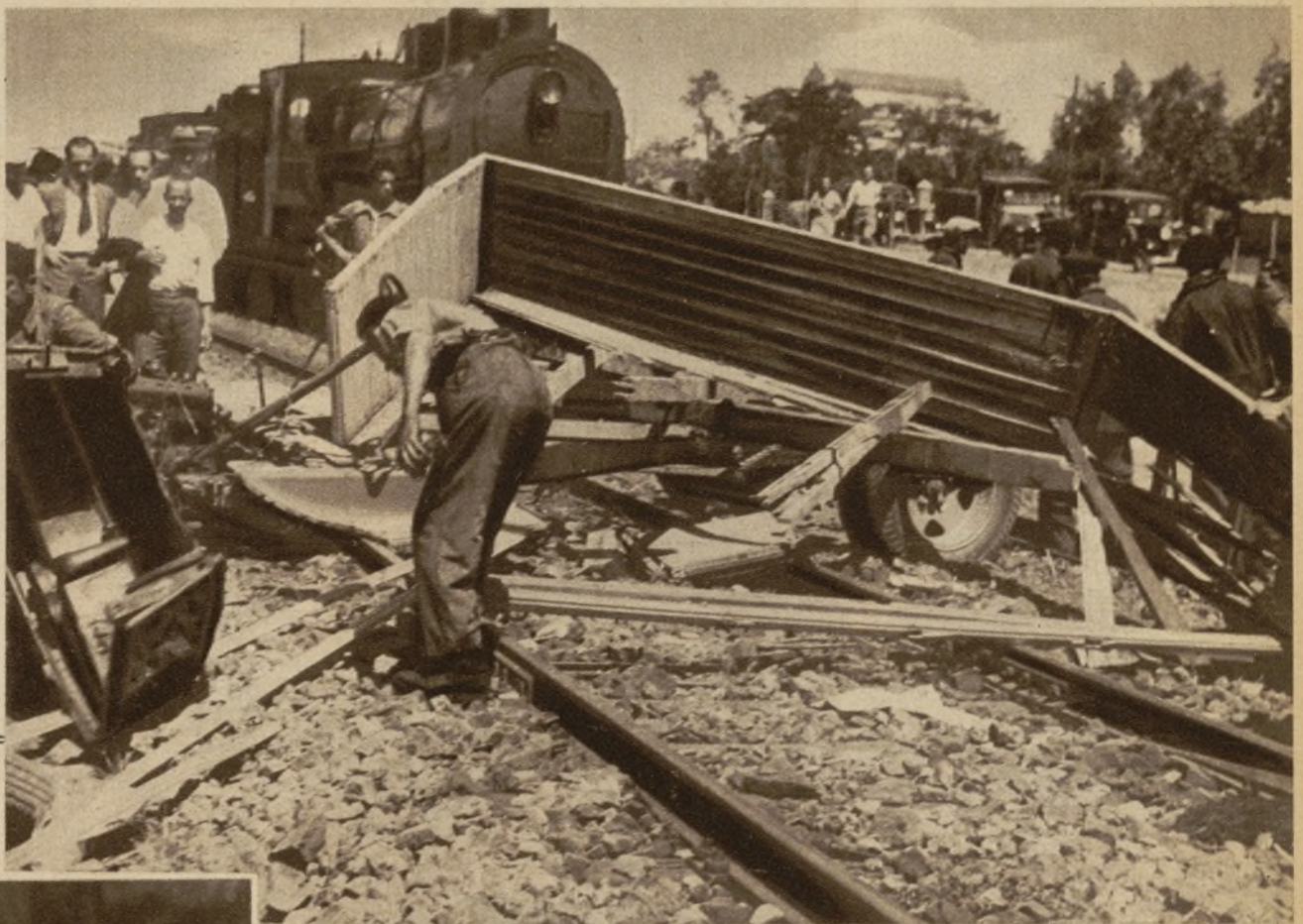
Restos de un camión de carga que fué destrozado en las proximidades de Madrid, en un paso a nivel, por el tren expreso de Galicia. Por fortuna, no hubo desgracias personales, pues los ocupantes abandonaron a tiempo el vehículo (Foto Tello)
