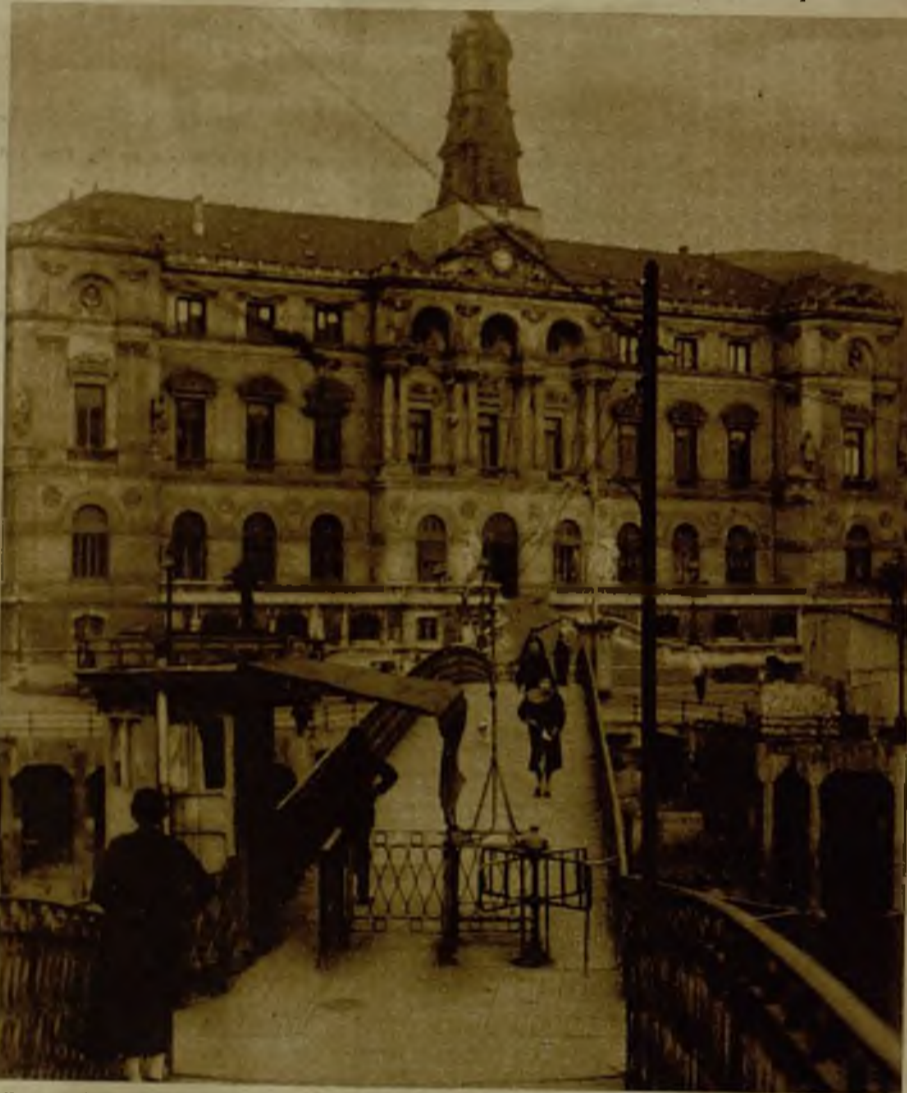
El puente condenado a muerte por el progreso urbanístico, daba carácter a la fisonomía de la villa, en el lugar donde está emplazado
