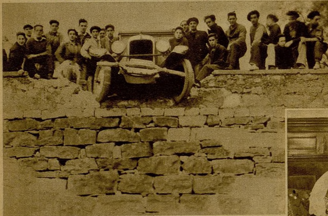
Estado en que quedó un automóvil que en las proximidades de Zumaya se estrelló contra el muro de un puente. Por fortuna, los ocupantes resultaron ilesos
