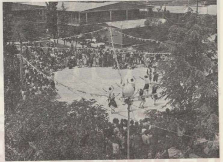
En la nueva plaza de la UVA, orgullo del barrio con su piso e iluminación, baila el grupo de baile del Centro Asturiano en la «Fiesta del Bollo» de la pasada primavera. (Foto: F. Ugarte.)
