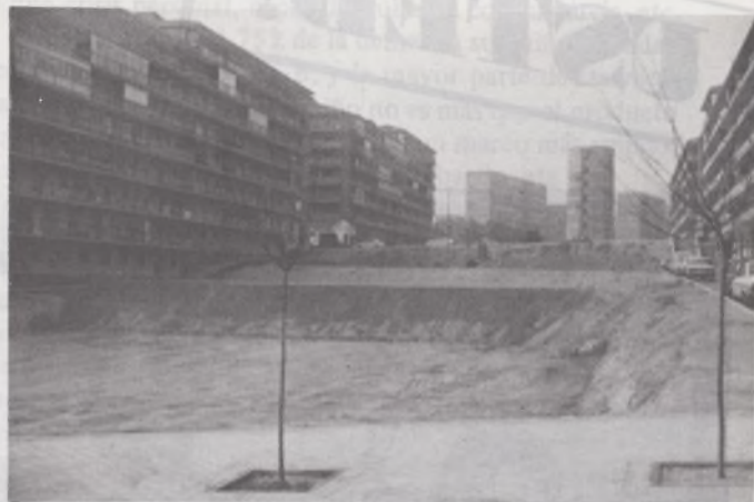
ZONA DEPORTIVA DE VIRGEN DE LA SALUD. Este es el estado que presentan actualmente las obras del pabellón deportivo. Su finalización está prevista para el mes de Marzo. En nuestro local de Virgen de la Salud tenemos el proyecto del que podemos dar cumplida información a los vecinos que lo soliciten.
