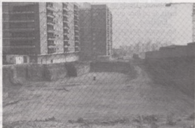
EN MARCHA LAS OBRAS DEL PARKING MUNICIPAL. En la foto ofrecemos la imagen de las obras que darán una mayor expansión al espacio que comprende Sta. María y Virgen de la Salud al quedar libre las zonas que hasta ahora se ocupan con el aparcamiento de vehículos. Queremos recordar que está prevista su conclusión para el próximo mes de Junio.
