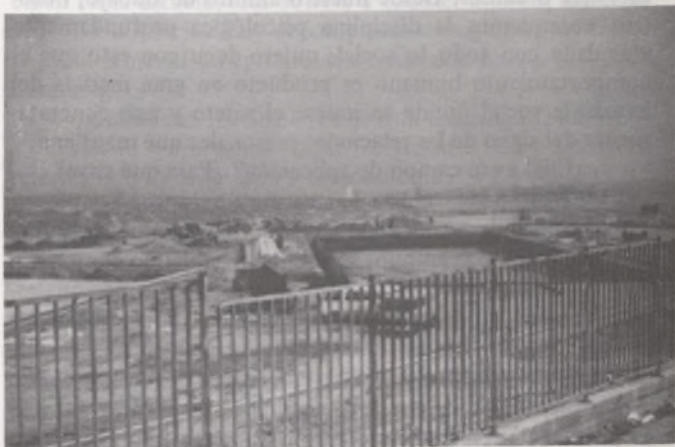
POLIDEPORTIVO DE HORTALEZA: LAS PISCINAS EN FASE AVANZADA DE CONSTRUCCION. En la foto observamos el estado actual de las piscinas del polideportivo, cuya primera fase está prevista que finalice el próximo mes de Abril. Confiamos que éste verano podamos todos disfrutar de las mismas. Adelantamos que ya se está empezando a preparar la realización de la segunda fase del proyecto.
