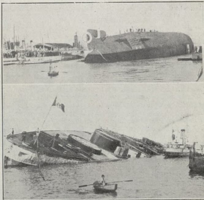
Cerradas todas las entradas de agua el barco vuelve al mar y allí se le hace dar la vuelta haciendo maniobrar las válvulas que inundan determinados compartimentos estancos.
