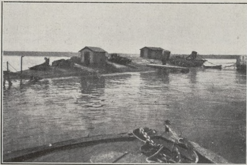
El «Leonardo de Vinci» hundido en el puerto de Tarento, con la quilla al aire en la forma que quedó después de la explosión. Las casetas que se ven sobre el casco, se construyeron para guardar el material de salvamento.
