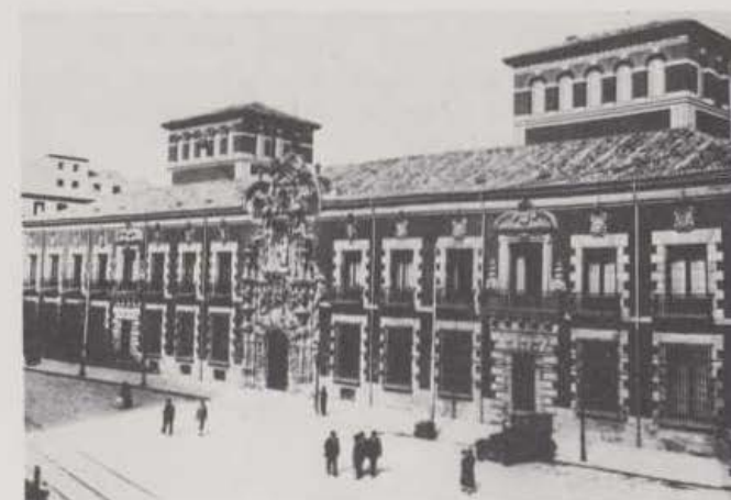
El edificio, ya restaurado en 1926.
