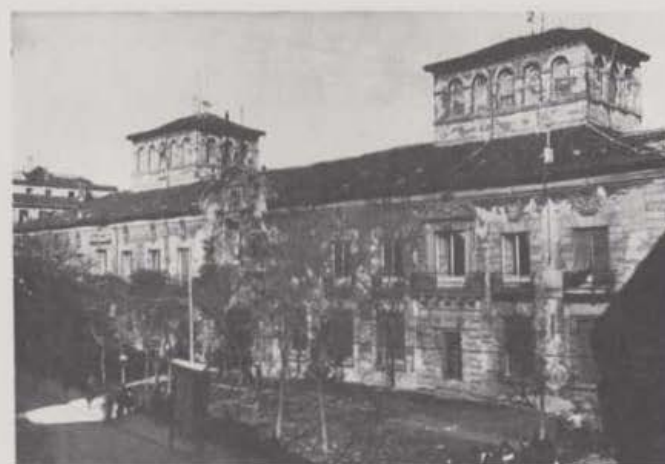
Estado ruinoso de la fachada del edificio antes de la restauración de 1926.
