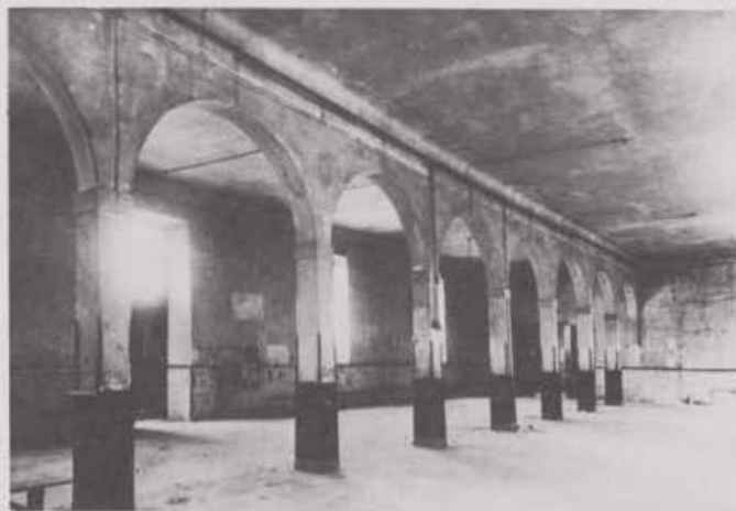
Situación de abandono de una de las naves del piso bajo antes de la reforma de 1926.
