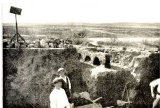
Es estructura identificada como posible acueducto
