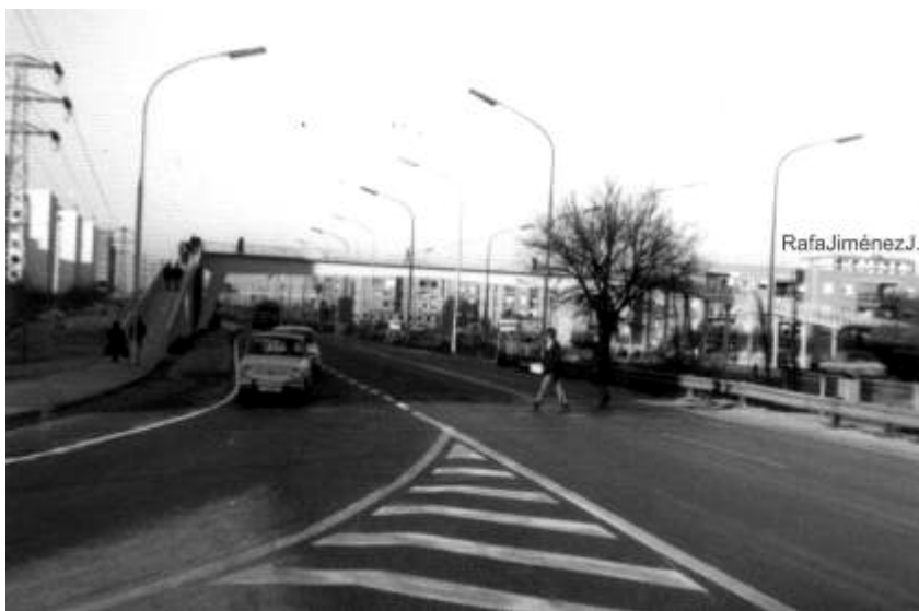
La carretera de Andalucía a la altura del Cruce de VillaVerde (Foto: Rafael Jiménez)
