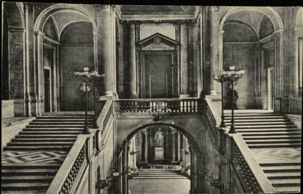
52 MADRID. — Palacio Real: Escalera principal.
