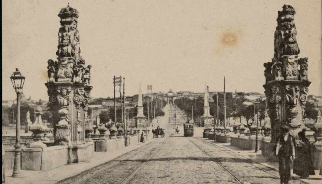
67. MADRID. — Puente de Toledo.
