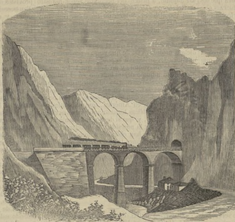
Camino de hierro del Norte de España.—Grandes v'aductos antes de llegar al túnel de Pancorbo. (Véase pág. 8).
