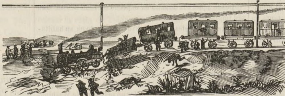
Catástrofe ocurrida en el camino de hierro entre Almansa y Alpera, en la noche del 28 de noviembre.
