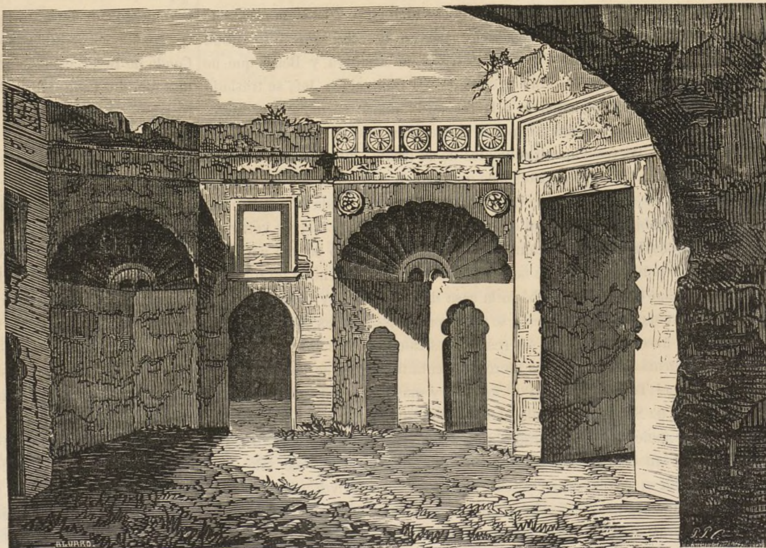
Restos de un salon completamente arruinado en el interior del Serrallo.
