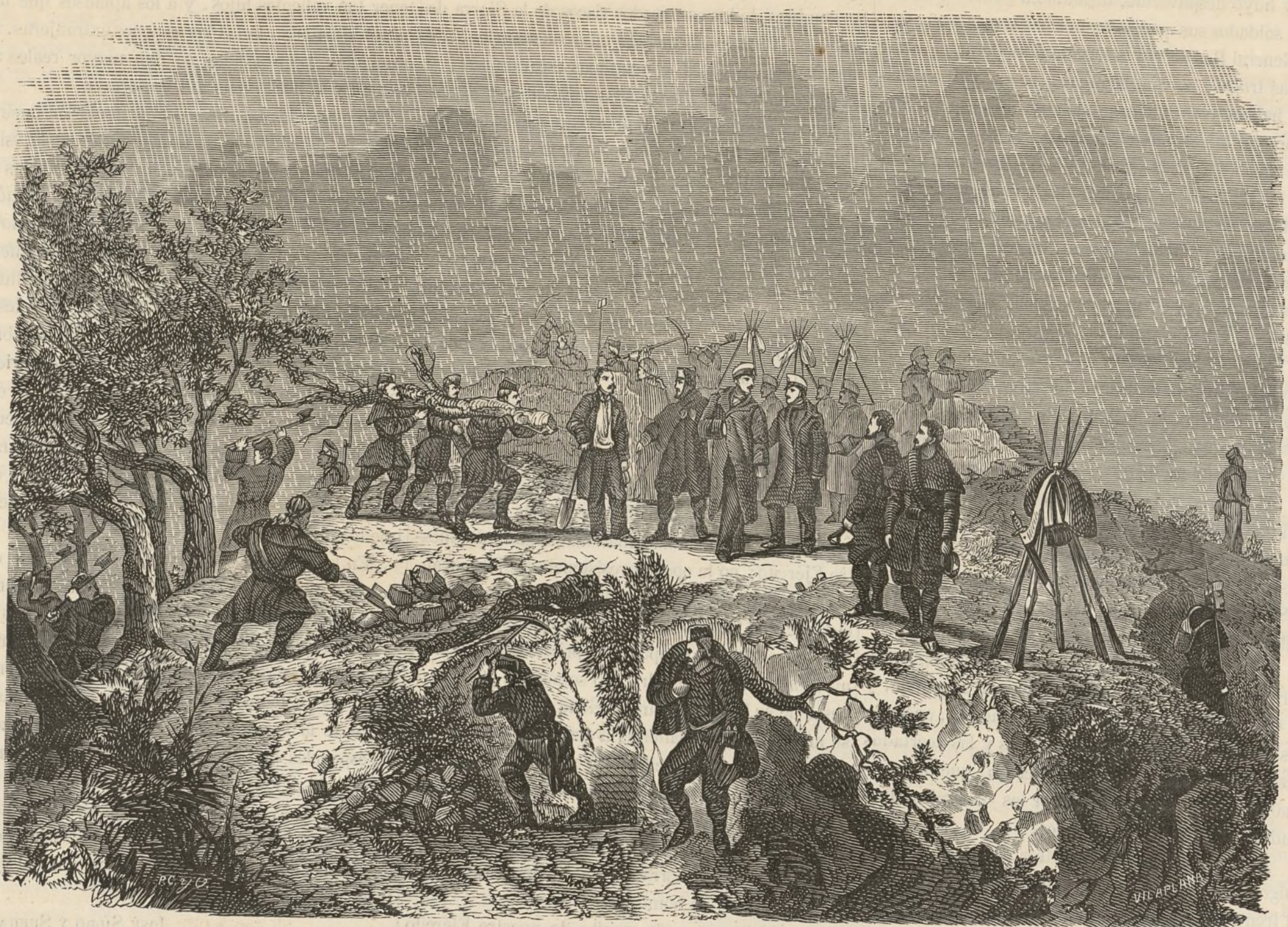
Visita hecha por los Excmos. Sres. Conde de Lucena y general Zavala, el día 5 de diciembre de 1859, á los trabajos del reducto denominado ESPAÑA.
