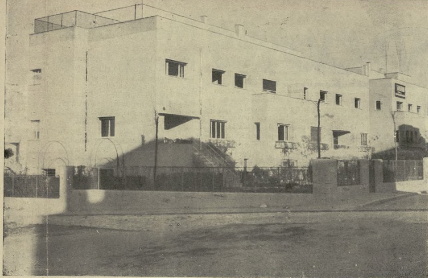
Vista exterior del Sanatorio
