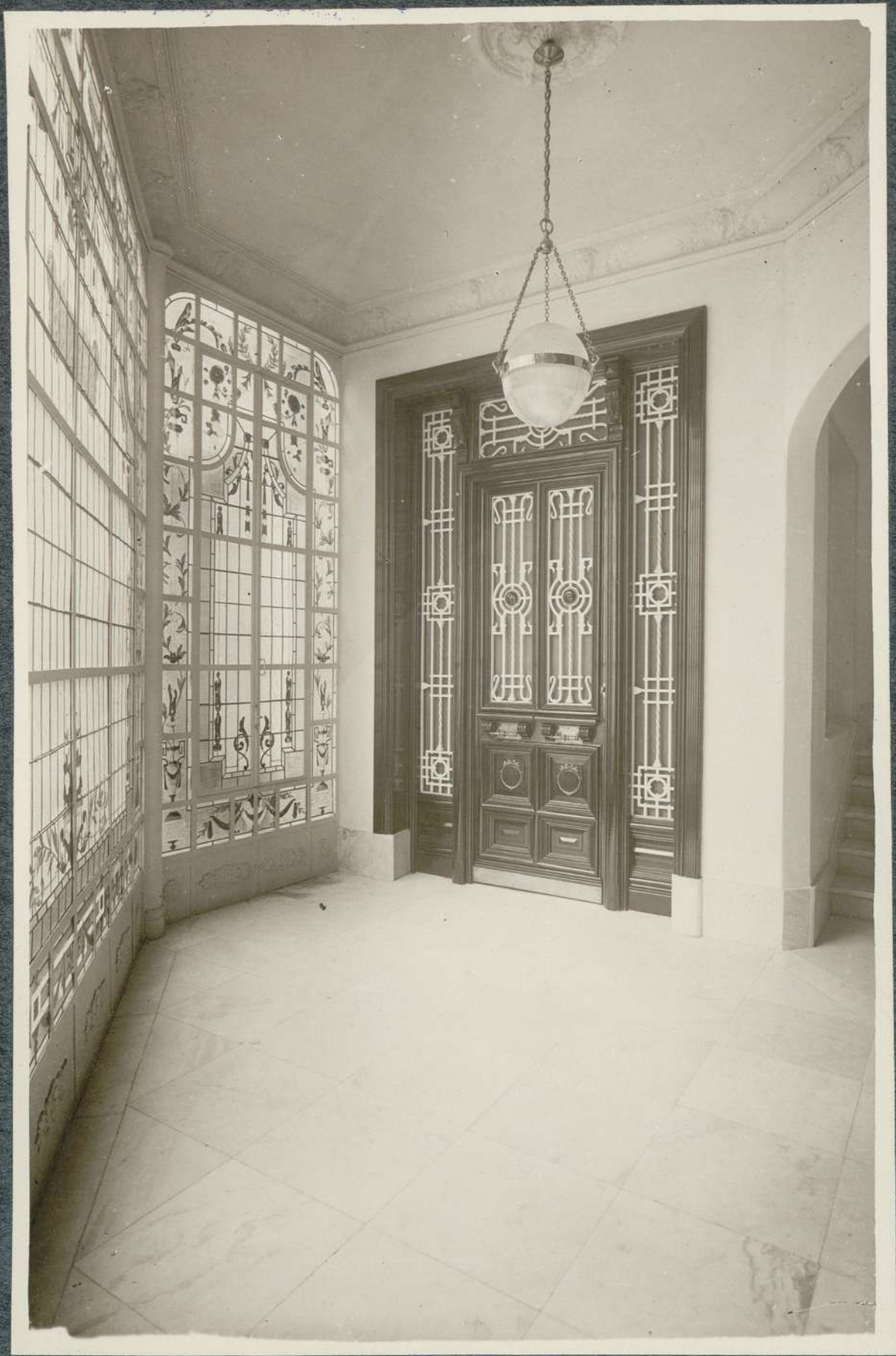
Escalera -Galeria y entrada de piso
