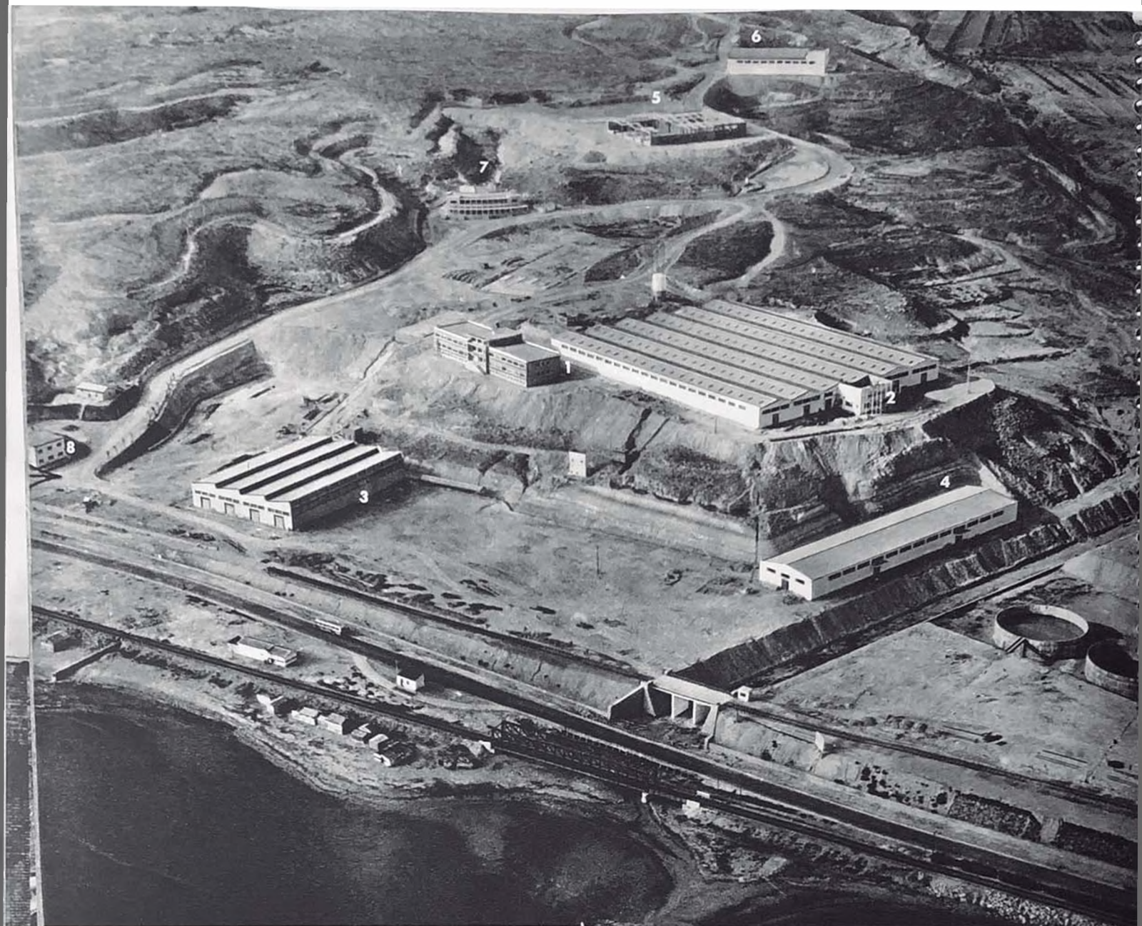
VISTA AEREA DE LA FACTORIA DE ALICANTE
