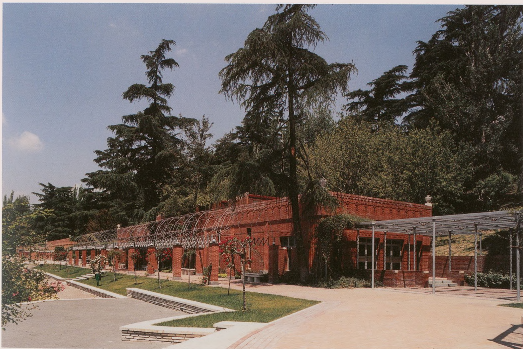
Los nuevos pabellones, concluidos.
