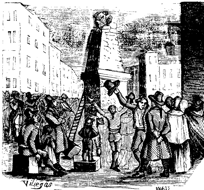
DERRIBO DE LA PIRÁMIDE DE RONCESVALLES.
