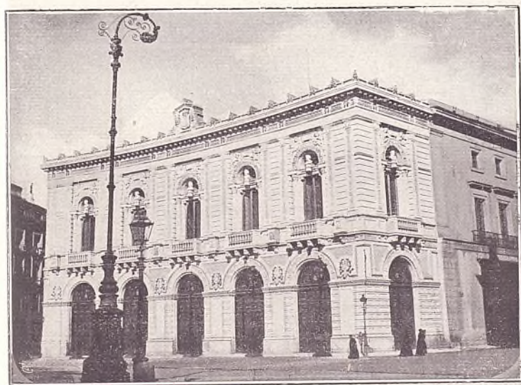
Teatro Real.—Fachada de la Plaza de Oriente.
