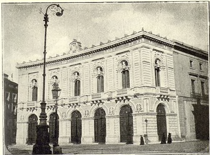
Teatro Real - Fachada de la Plaza de Oriente
