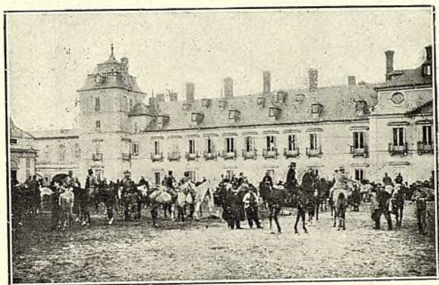
Vista exterior del Real Palacio de El Pardo
