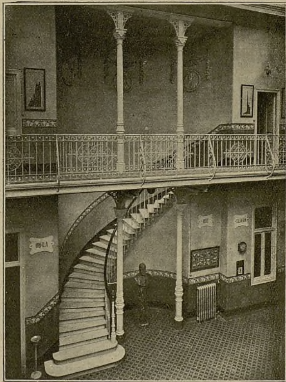
Patio cubierto del Laboratorio.
