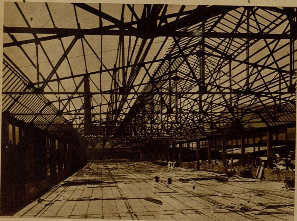
La nueva fábrica de automóviles que se está construyendo en Zorroza (Bilbao) por la S. E. I. D. A., Sociedad Anónima
