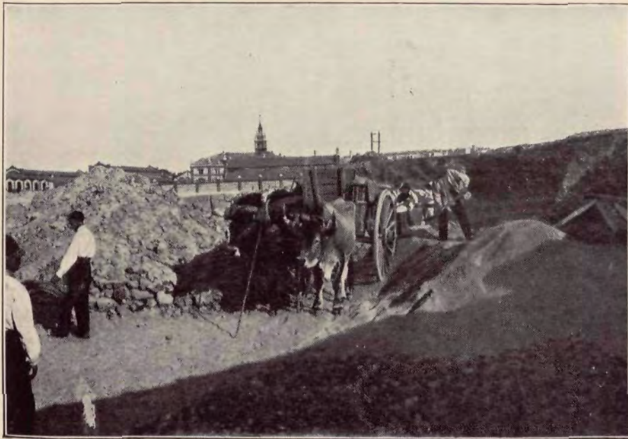
EL SOTILLO: Vista de los cortes al principio de nuestros trabajos.
