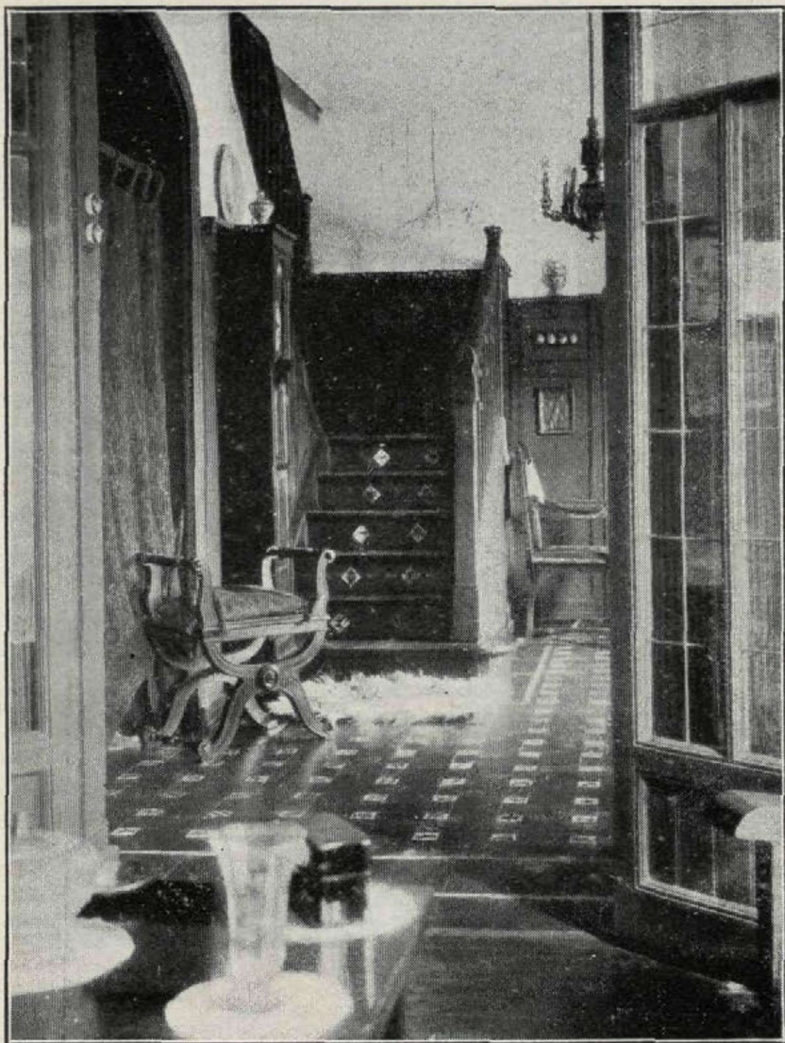
Vista del "hall" desde la sala. Al fondo, la escalera de madera que asciende hasta la planta primera. En el rellano se une con la que viene desde la cocina. De esta forma se evita la caja de la escalera y se consigue el paso del servicio sin atravesar el "hall".
