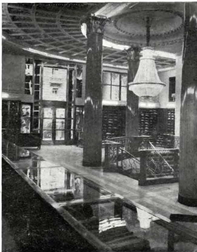
Dos aspectos del interior: los mostradores- vitrinas...
