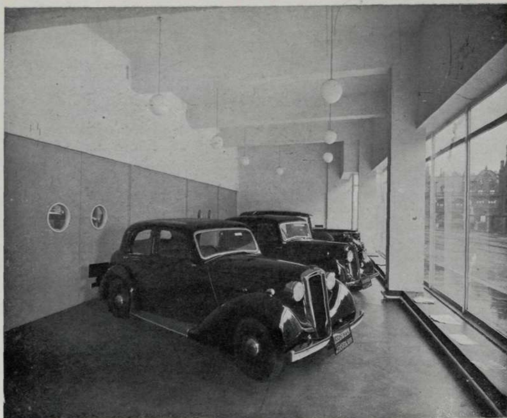
Automóviles expuestos tras los ventanales de la planta baja.
