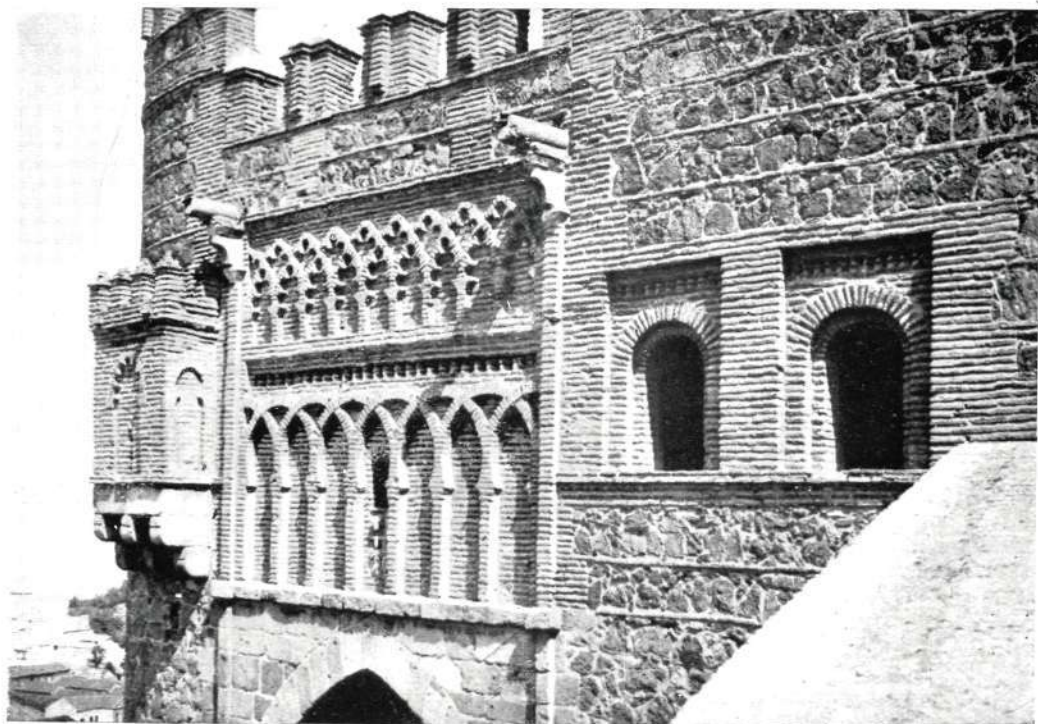
La Puerta del Sol, en su cuerpo superior, es una obra mudéjar, con arcos enlazados, ojimeces y matacanes.
