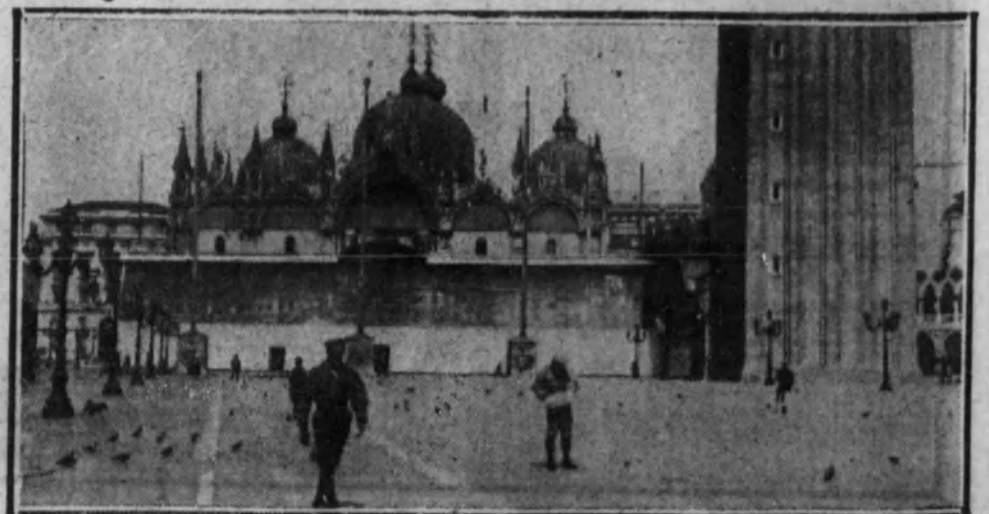
LA GUERRA EN ITALIA.—Aspecto que en la actualidad ofrecen las fachadas de los edificios y monumentos artísticos para aminorar los efectos destructores de los bombardeos.
