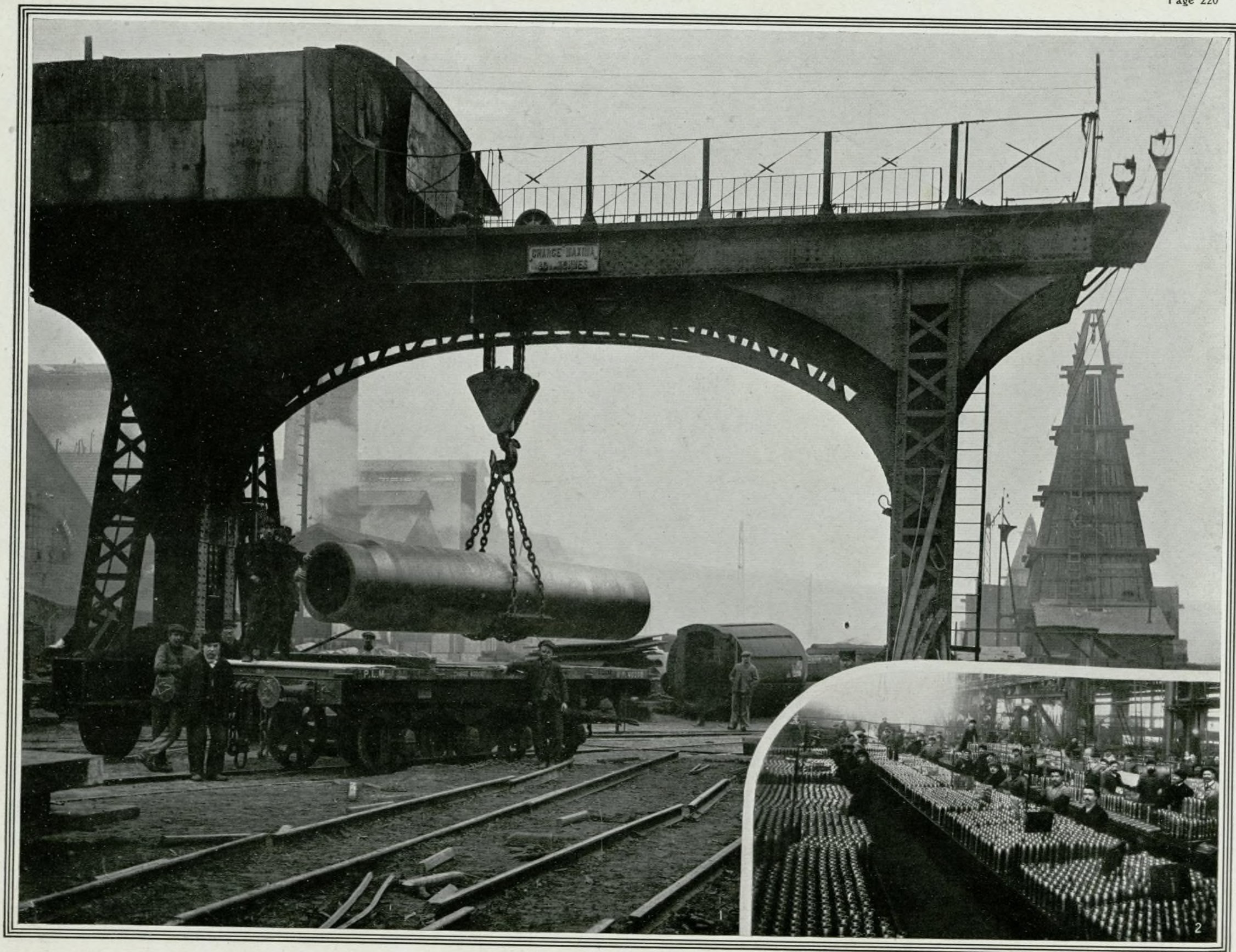
1. Chargement d'un corps arri re pour canon. — 2. Un atelier de v rification finale d'exp dition des obus de 75 explosifs.
