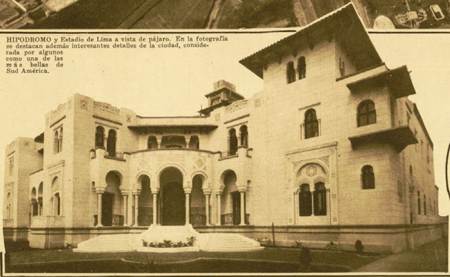
RESIDENCIA particular de la familia Grana, en Lima, que pone de relieve el buen gusto que predomina en la edificación moderna en la capital del Perú.
