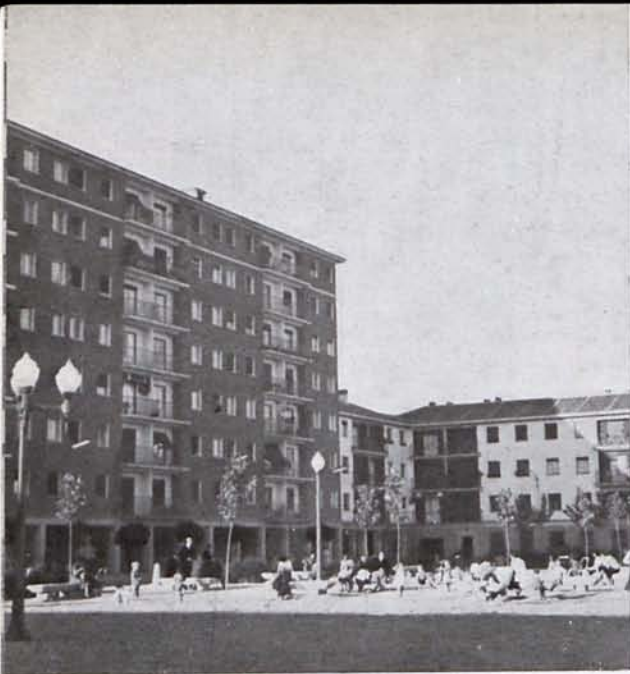
Barrio popular en construcción.
