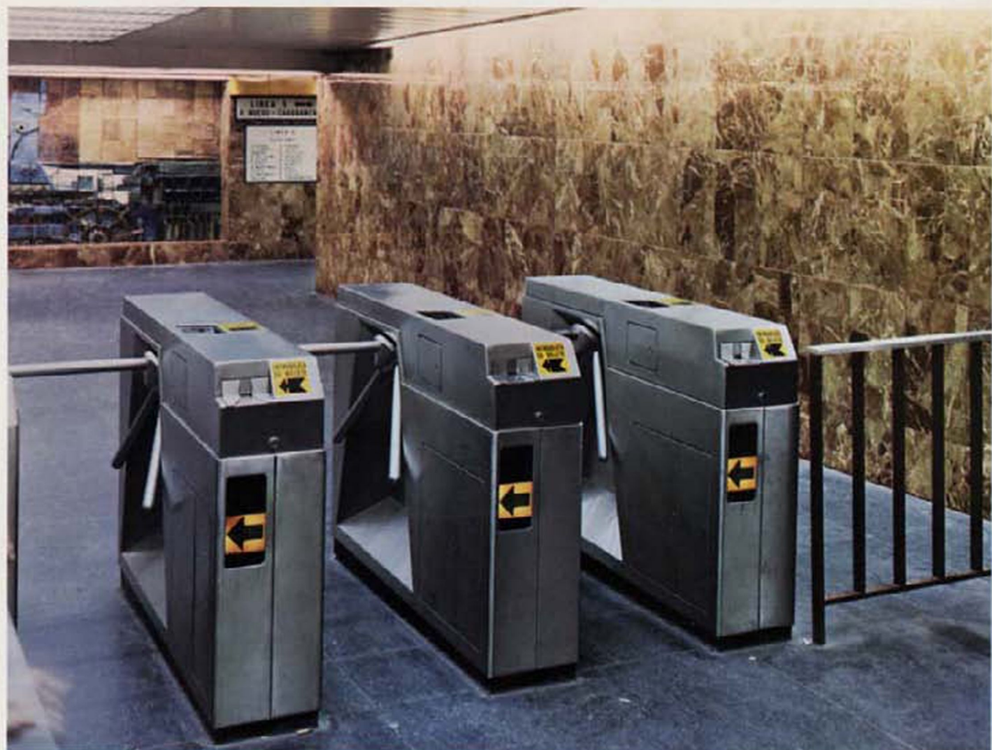
Torniquetes para el control de billetes magnéticos.
